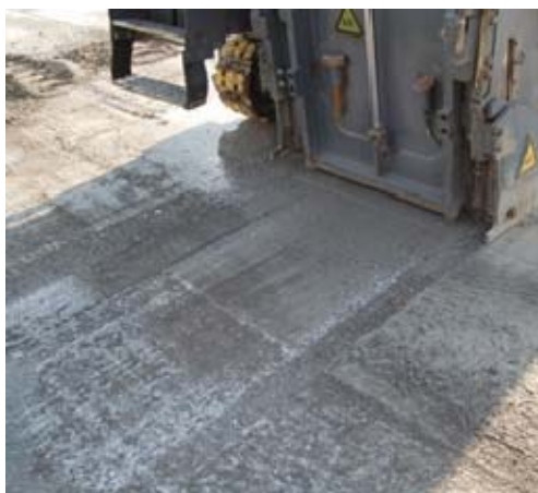
Abbildung 1: Herstellung der Oberflächen sowie digitales Oberflächenmodell einer längs und quer gefrästen Oberfläche
