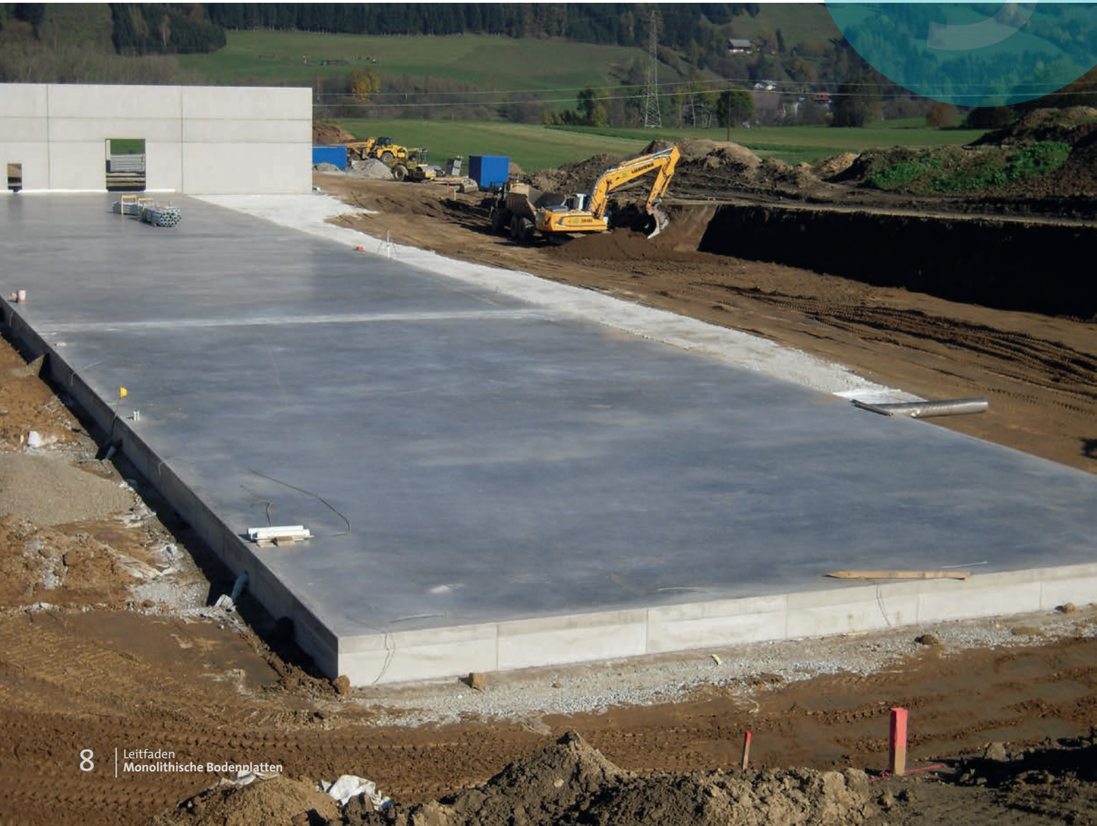
Fertig gestellte monolithische Betonplatte für eine Werkshalle
