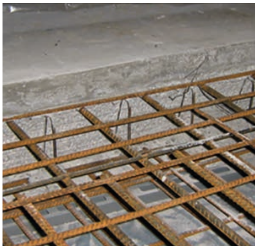
Betonierfuge mit Streckmetall
