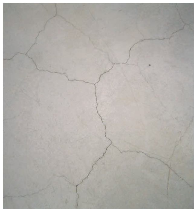
Risse mit Rissbreiten < 1 mm
