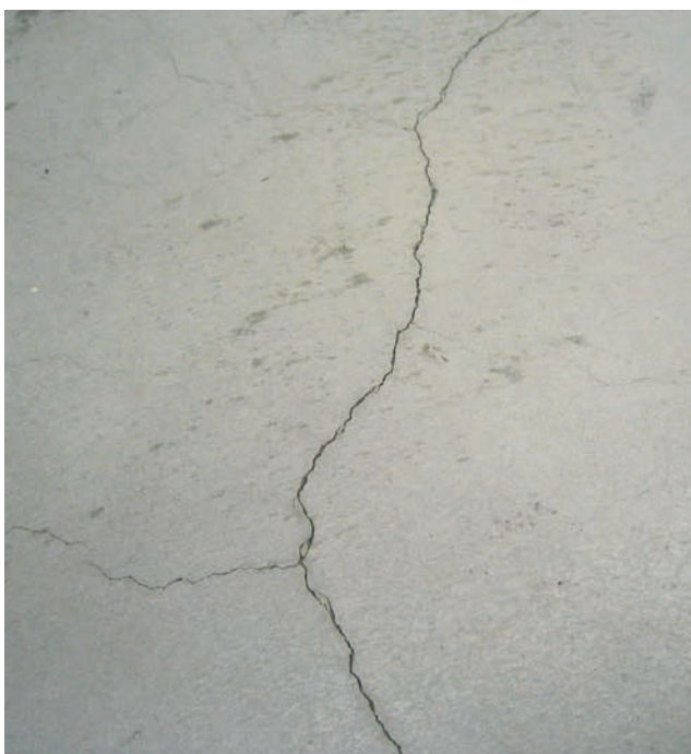
Risse mit Rissbreiten > 1 mm
