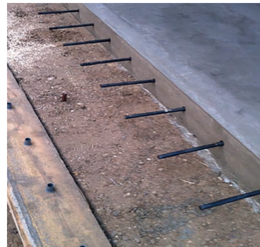
Arbeitsfuge mit Verdübelung
