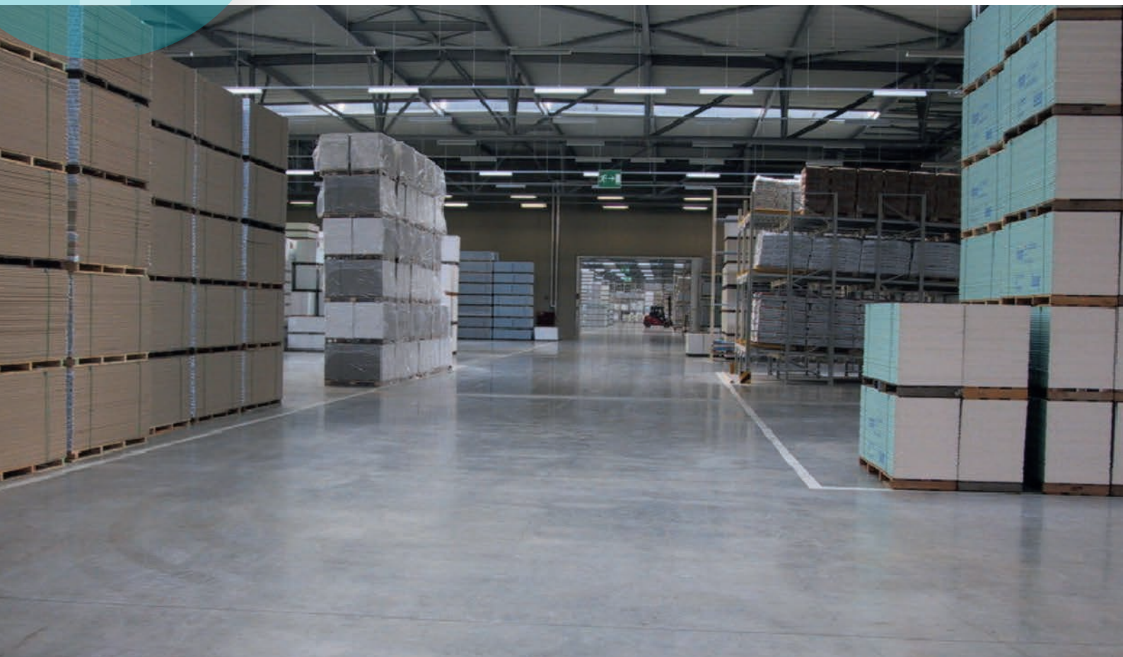
Monolithische Betonplatte einer Lagerhalle in Betrieb
