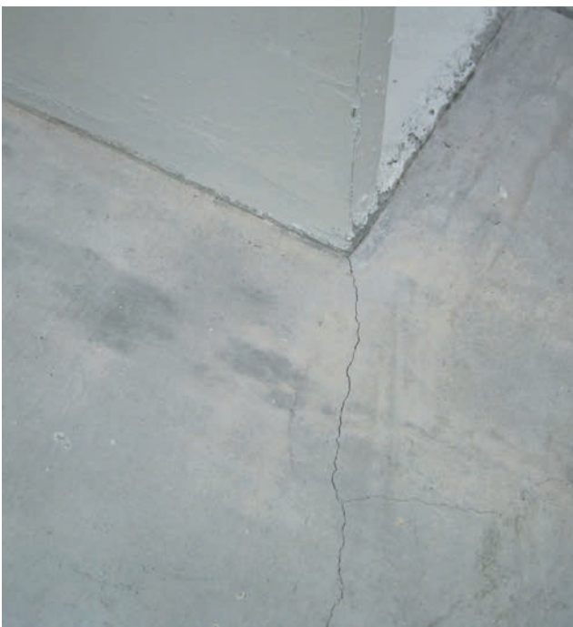
Riss im Eckbereich
