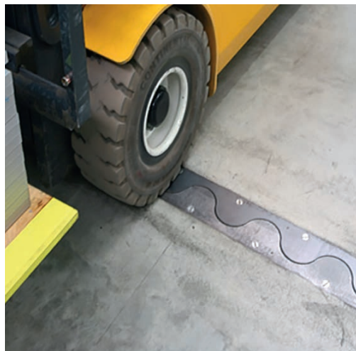
Profilfuge mit Sinusverlauf
