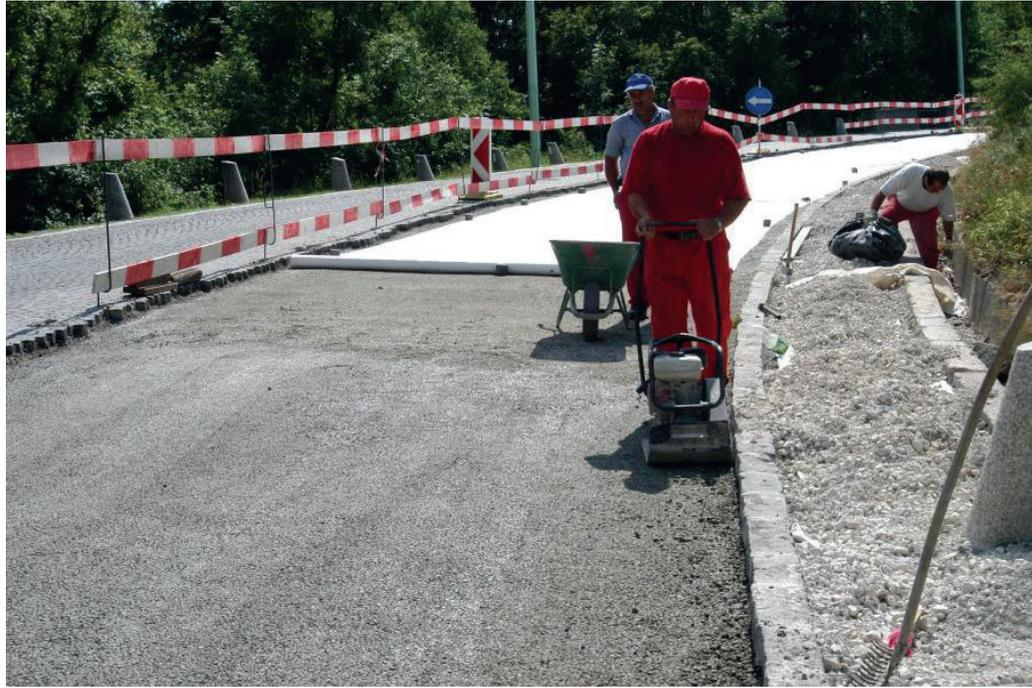
Bei Anwendung obiger Rezeptur und optimalen Einbaubedingungen (Verdichtung, Nachbehandlung) kann von einer Festigkeitsklasse C16/20 ausgegangen werden.
