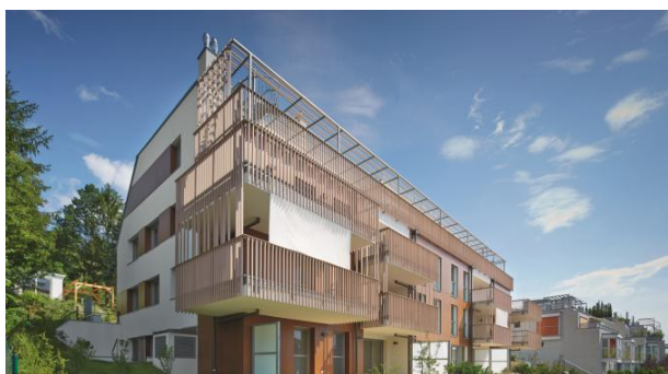
Wohnanlage mit 11 Einheiten 1160 Wien , Fertigstellung 2014, Bauträger Sedlak Immobilien GmbH Kältebereitstellung durch Sole/Warmwasserpumpen, Kühlung über Betondecke
