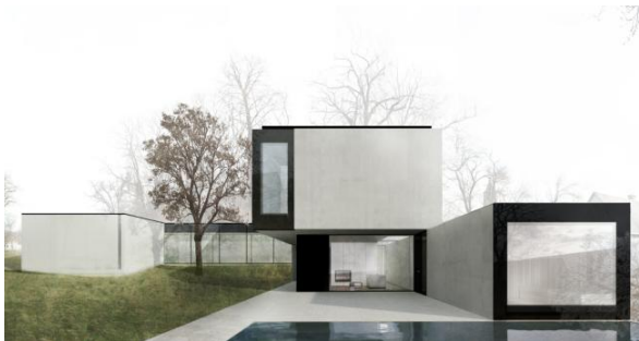
Einfamilienhaus Ober Grafendorf/NÖ , Fertigstellung 2015 Architekten Bauer Fröhlich ZT GmbH Betonwände im Erdgeschoß und Obergeschoßdecke bauteilaktiviert
