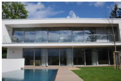
Einfamilienhaus 1170 Wien , Fertigstellung 2013 martin rührschopf architecture Solaranlage, Bauteilaktivierung zur Kühlung
