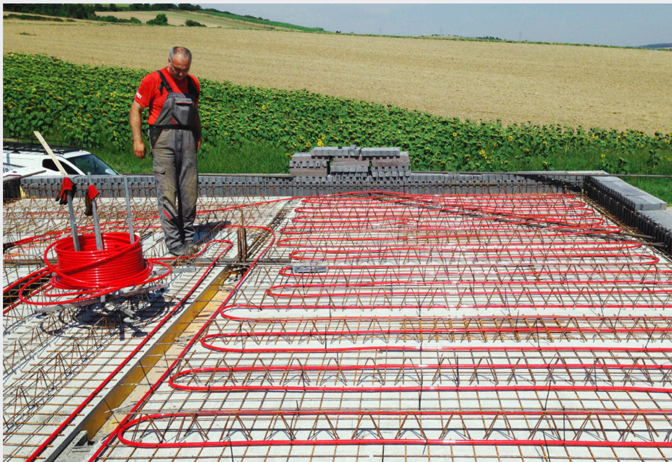
Pilotprojekt: Der Einbau der Rohrleitungen zur thermischen Aktivierung der Decke ist unkompliziert und kostengünstig.
