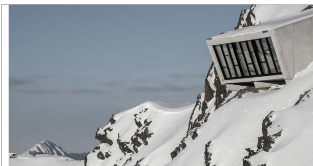
007 Elements-Baukörper mit Panoramablick ins Venter Tal
