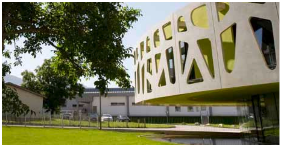
Kirchdorfer Zementwerke: Zukunftsweisender Einsatz des Energiespeichers Beton
