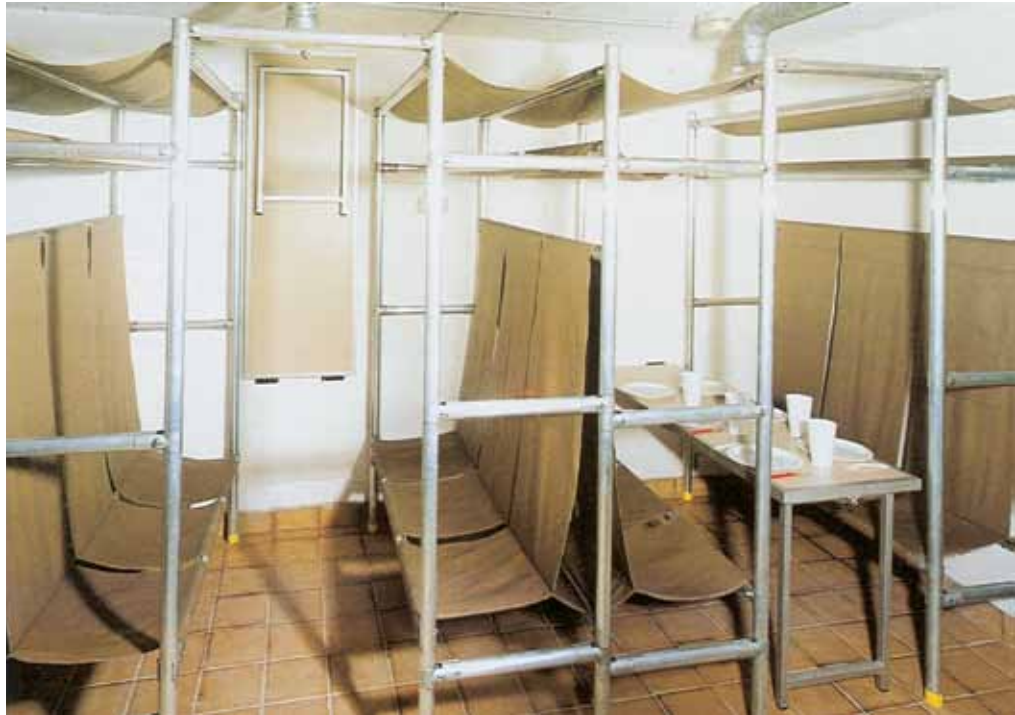
Bild 21: Der Raumbedarf eines Schutzraumes ergibt sich aus der Anzahl der notwendigen Schutzraumplätze, dem nötigen Luftbedarf sowie dem Platzbedarf für Toilette, Waschgelegenheit, Lüftungsanlage sowie Vor- und Nebenräume (Foto: Firma Krobath)
