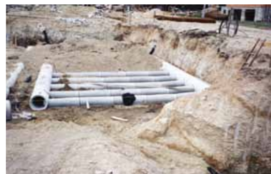
Bild 31: Luftkollektor-Verlegung (Foto: EVN)
