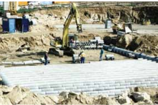
Bild 32: Luftkollektor-Verlegung (Foto: EVN)
