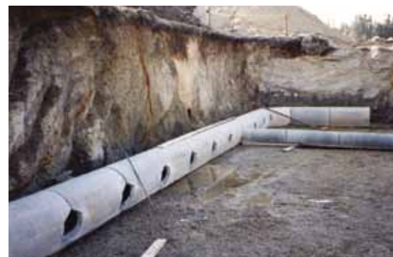
Bild 30: Luftkollektor-Verlegung (Foto: EVN)
