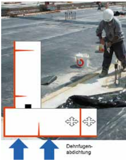
Grafik 4-27: Wirkung der Bentonitschicht (Aufquellen bei Feuchtezutritt)
