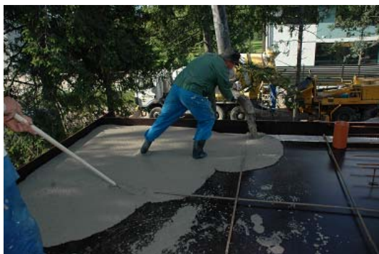
Abb. 13 + 14 Betoniervorgang eines TAB-Slab-Projektes in Tallinn/Estonia, Kolde Tee
