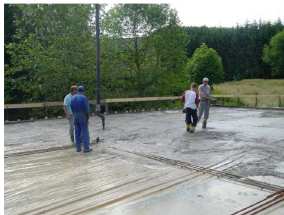
Abb. 4 Betoniervorgang der TAB-Slab®-Testdecke in Bissen – problemlose Pumpbarkeit des hochdosierten Stahlfaserbetons
