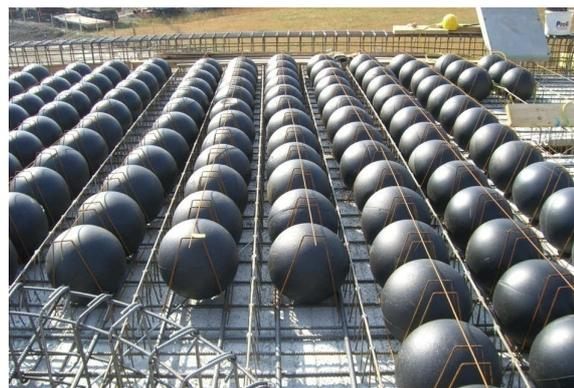
Teilfertiglösung – Cobix CBCM-eco auf Elementdecke aufgelegt
