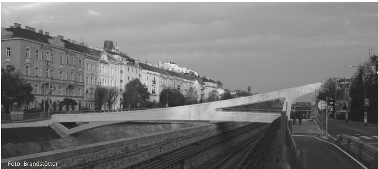
Abbildung 1: Steg Astgasse, mit Weißzement ausgeführte Fuß- und Radwegbrücke über den Wienfluss
