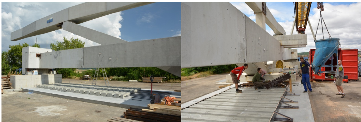
Abbildung 2: Prototyp vor und während dem Betonieren
