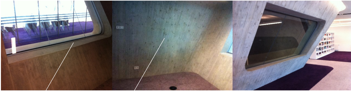
Leibungen (Unterschnitt) Sanierungsfall
