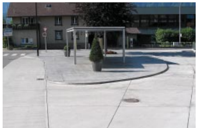
Bushaltestelle Thüringen: Platteneinteilung mit optischer Differenzierung
