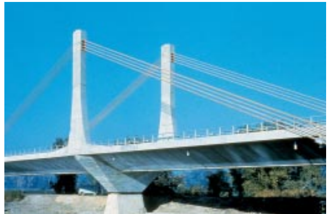
Schrägseilbrücke über den Donaukanal, Wien
