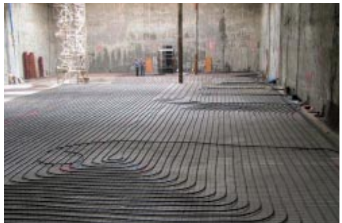
Energiebodenplatte bei der Wiener U-Bahn-Station „Praterstern“
