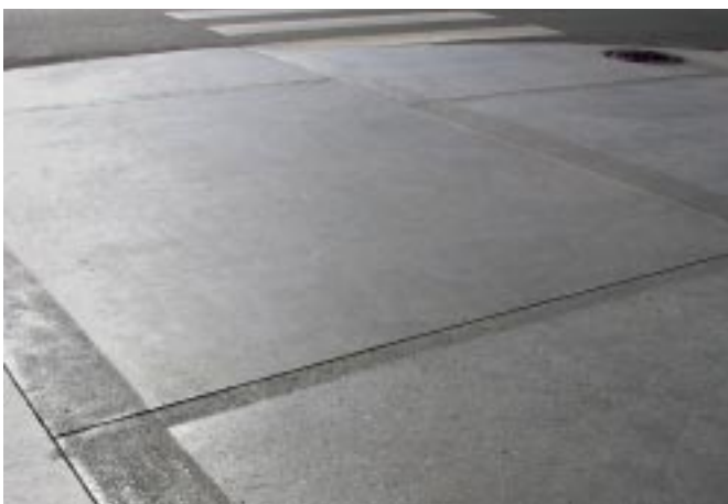
Bushaltestelle in Thüringen: Fugenbild und Oberflächengestaltung
