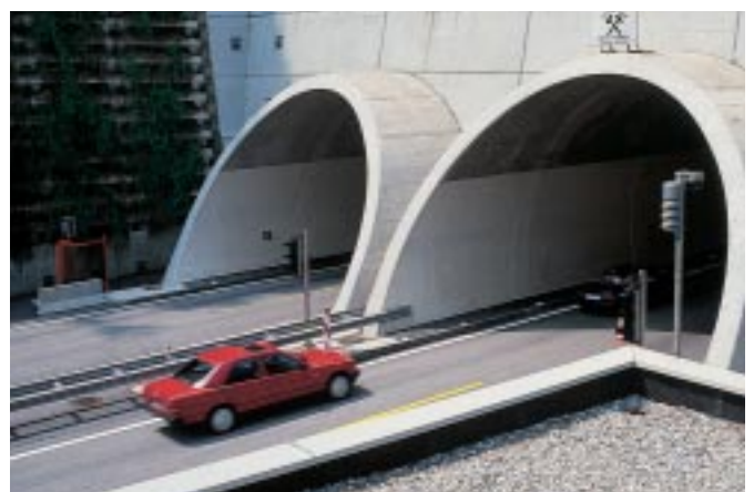
Grassbergtunnel, Semmering Schnellstraße
