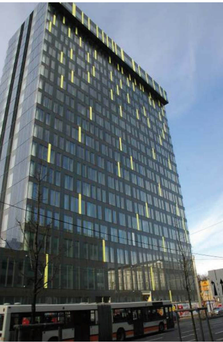
Bild 1: Ansicht Power Tower
