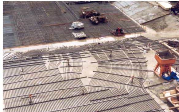
Abb. 1: HDPE-Absorberleitungen einer „Energiebodenplatte“, montiert auf der Sauberkeitsschicht eines Hochbaus
