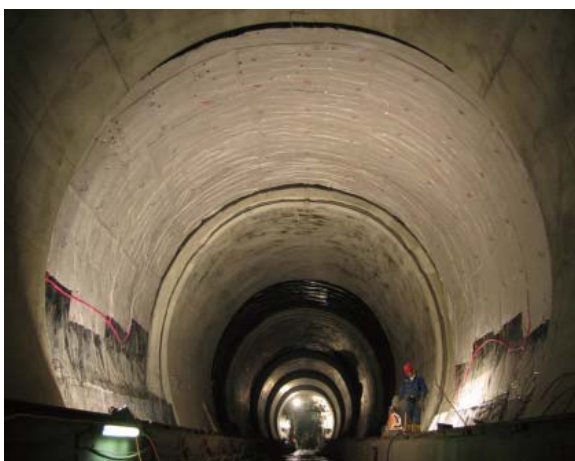
Abb. 7: Versuchsanlage mit Energievlies beim Baulos „LT22-Bierhäuselberg“
