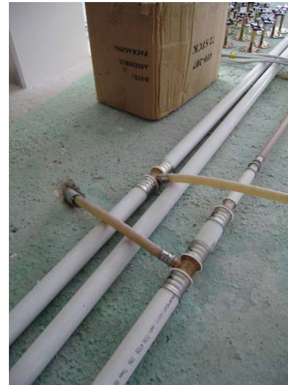
Abb. 8: Kupplungsstelle Decke
