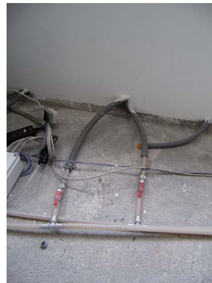
Abb. 9: Kupplungsstelle Parapetwand
