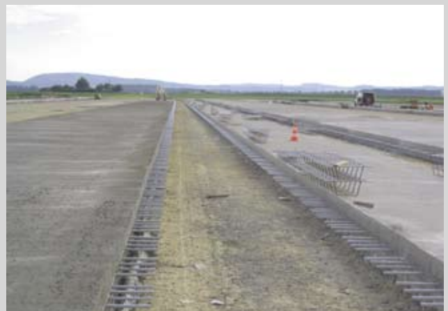
Abb. Nr. 2: Für den Gleiseinbau reservierter Bereich
