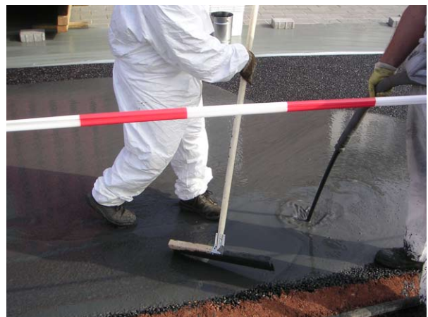
Bild 4: Vergießen und Verteilen des Mörtels
