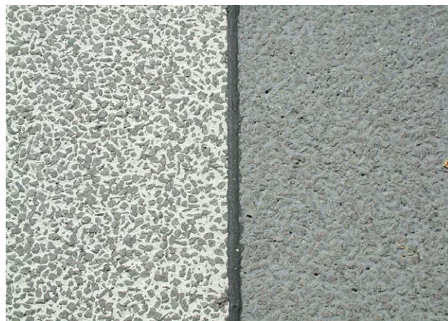
Bild 6: Fertige HD. Trennung der dunklen und hellen Decke durch Asphalt-Fuge
