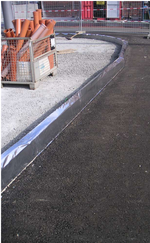
Bild 2: Asphaltträgerüst mit abgedeckter Bordsteinrinne
