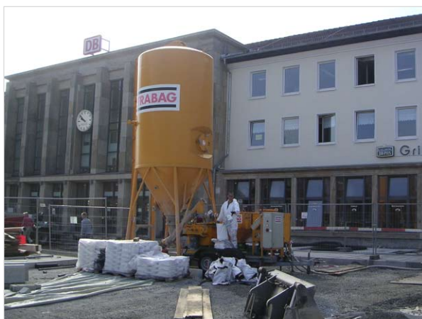
Bild 3: Mischanlage für den Vergussmörtel
