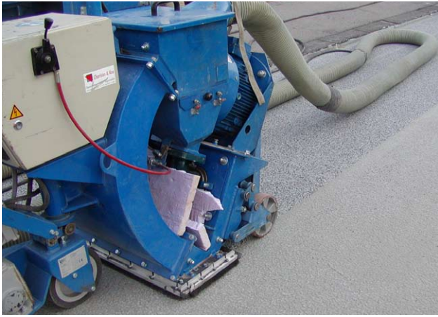
Bild 5: Kugelstrahlen der vermörtelten Fläche
