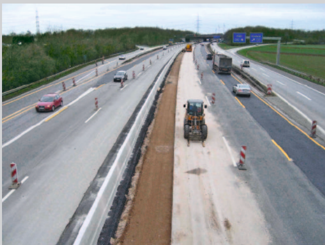
Bild 7: Bau einer frei aufgestellten Betonschutzwand
