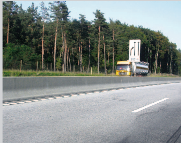
Bild 6: Betonschutzwand mit New-Jersey-Profil
