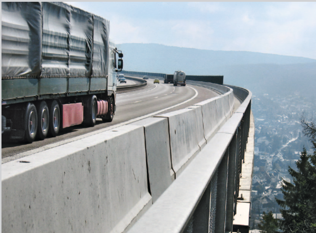
Bild 1: Absturzsicherung auf Brücken
