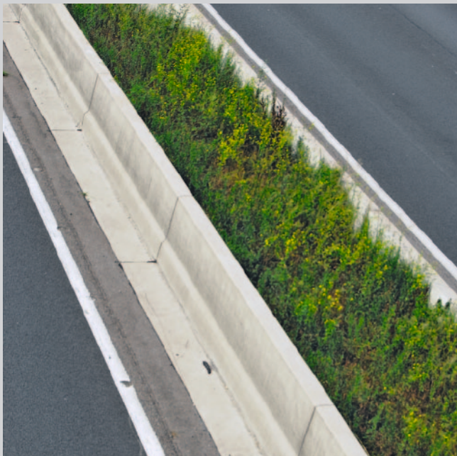
Bild 5: Betonschutzwand mit Step-Profil
