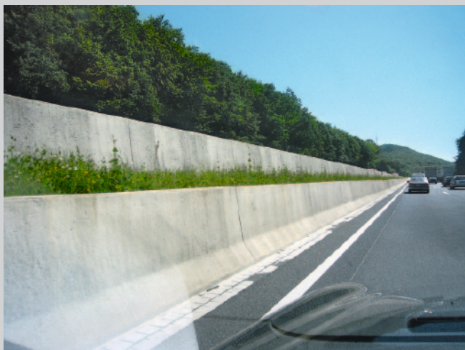
Bild 2: Schutzeinrichtung auf der Strecke
