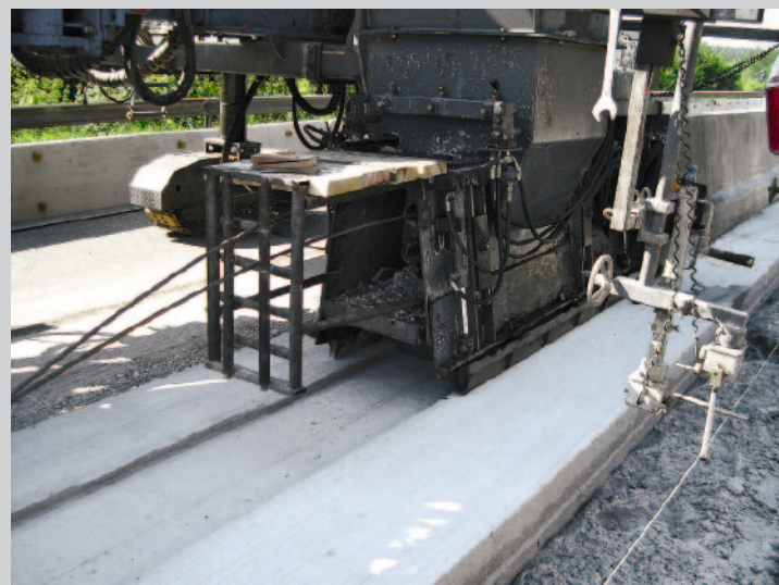
Bild 8: Bau einer eingespannten Betonschutzwand
