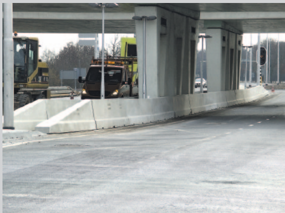
Bild 10: Schutzeinrichtung aus Beton an Brückenpfeilern
