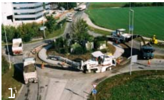
1. Tag, 10 Uhr: Der bituminöse Belag wird Bahn für Bahn ausgefräst.
