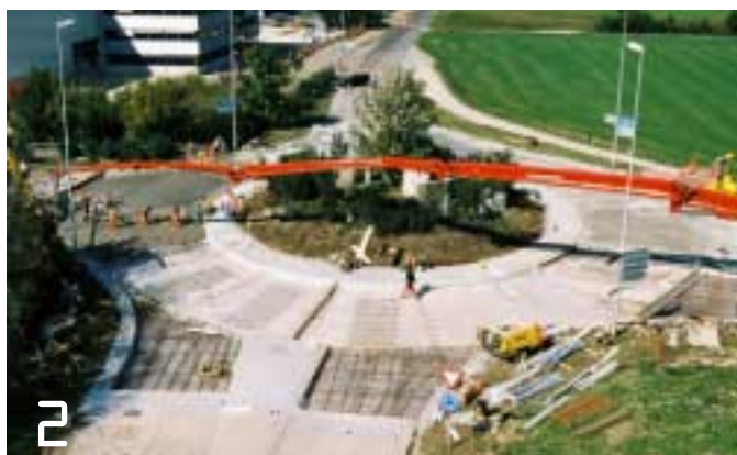
2. Tag, 14 Uhr: Gut die eine Hälfte des Kreisels ist betoniert.
