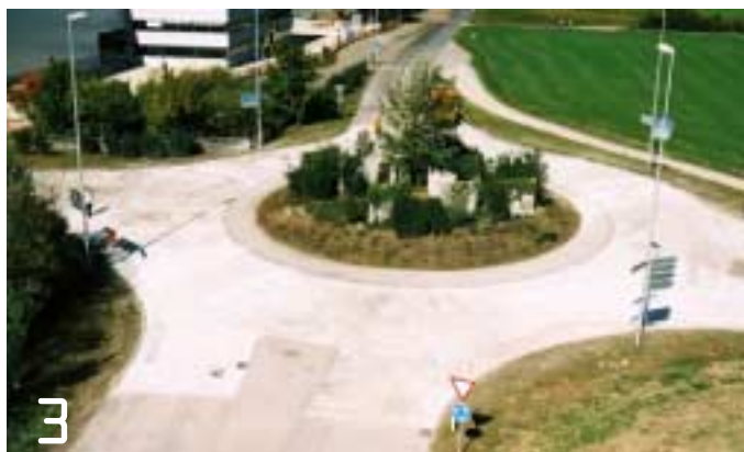
3. Tag, 14 Uhr: Die Nacharbeiten sind beendet, die Markierung wird gleich folgen.
