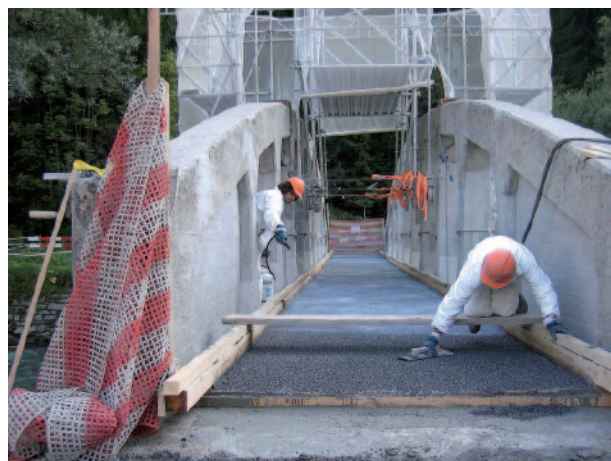
Einbau der multifunktionalen UHFB-Schicht (Verstärkung, Abdichtung, Fahrbahnbelag)
