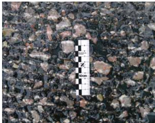
gefräste, gereinigte Asphaltfläche
