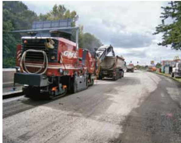
Asphalt fräsen
