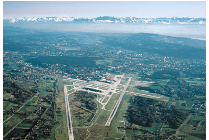
Flughafen Zürich von oben
