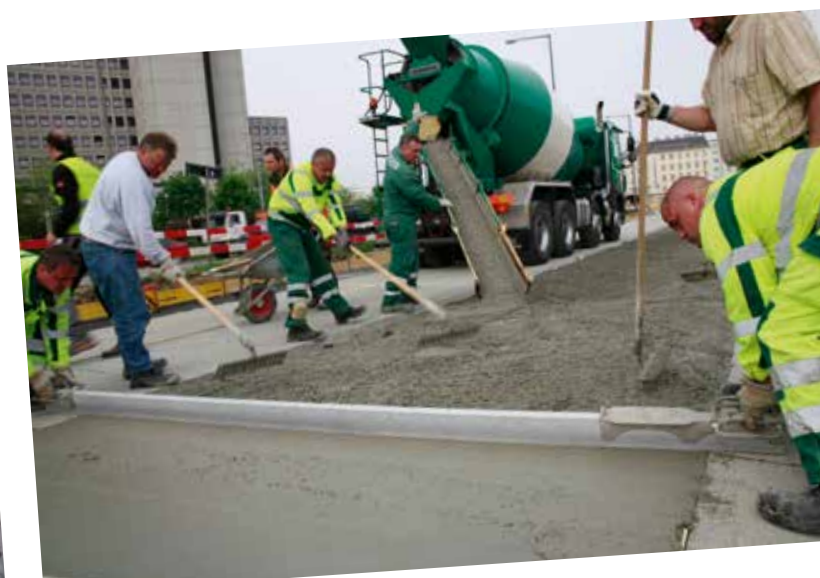
Verarbeitung des Frischbetons in zwei Schichten: „nass in nass“
