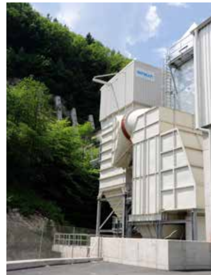
Klinkerkühler mit Filter
