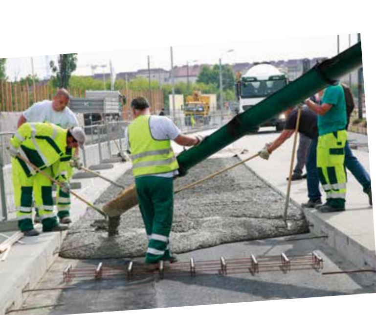
Verarbeitung des Frischbetons in zwei Schichten: „nass in nass“
