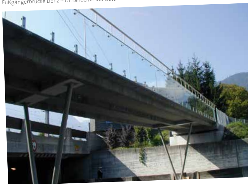
Fußgängerbrücke Lienz – Ultrahochfester Beton
