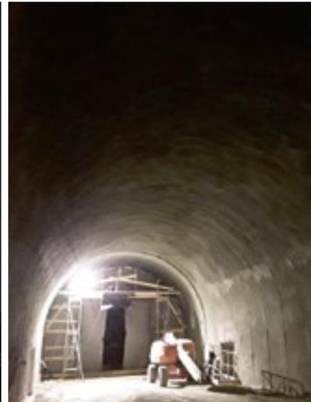
Der Tunnel erhielt eine gleichmäßige Tunnelinnenschale, die einfach gereinigt werden kann und zudem über ein optisch anspruchsvolles Erscheinungsbild verfügt. Das Bauunternehmen Habau zeichnete für die ausführenden Bauarbeiten verantwortlich, die Herstellung der neuen Spritzbetoninnenschale und das Aufbringen der Weißzementmörtelschichten erfolgte durch die Östu-Stettin und Vogl.Plus.
