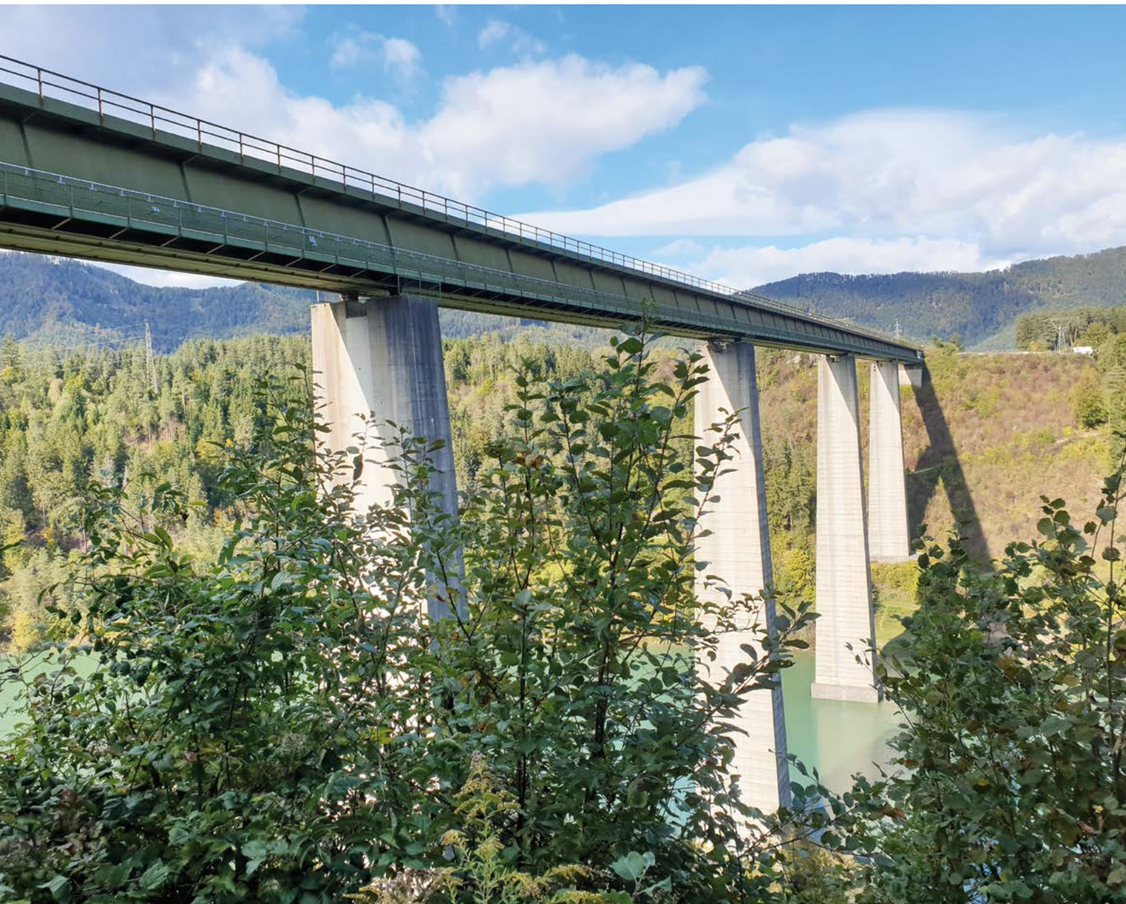
Infrastruktur-Meisterwerk aus Beton: Die Jauntalbrücke in Kärnten, ein Teil der Koralmbahn.
