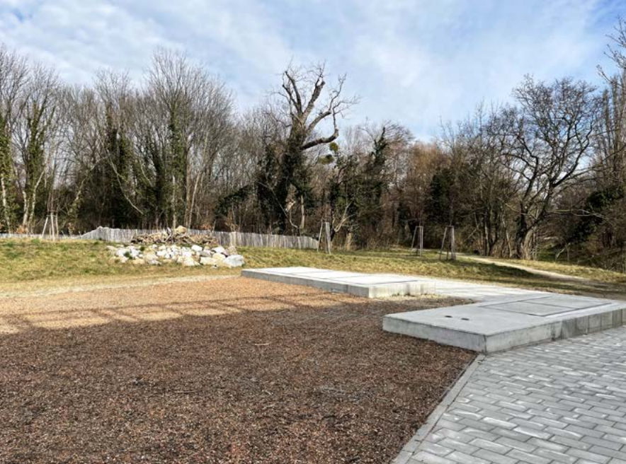
Die Abgänge zum Speicherbecken sind mit Betonplatten verschlossen.
