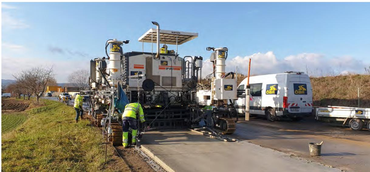
auch Spurrinnen und Verdrückungen dauerhaft instandgesetzt werden. „Der Vorteil der White-Topping-Bauweise liegt darin, dass ein großer Teil des vorhandenen Straßenaufbaus weiter genutzt werden kann und nur die oberste Schicht durch eine formstabile und langlebige Betondecke ersetzt wird. Dadurch kann diese Bauweise mit – im Vergleich zu einem Neubau – weit geringeren Kosten und unter Schonung von Ressourcen zur Ertüchtigung von Straßenabschnitten eingesetzt werden“, erläutert Peyerl.
