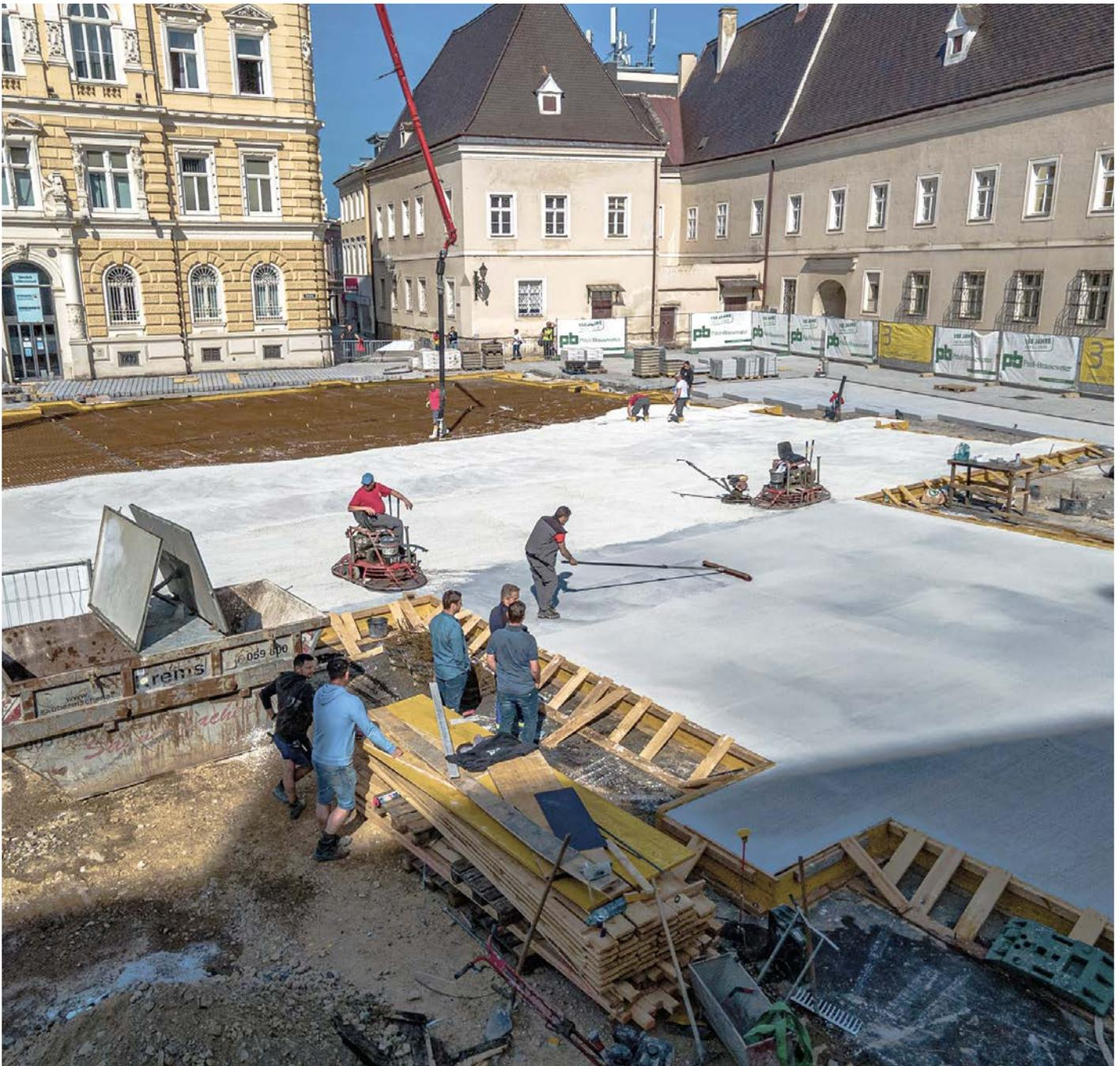
„Die Betonplatte hat eine Fläche von ca. 850 Quadratmeter und wurde mit Weißzement und hellen Zuschlagstoffen hergestellt, damit sie sich vom restlichen Platz deutlich hervorhebt.
