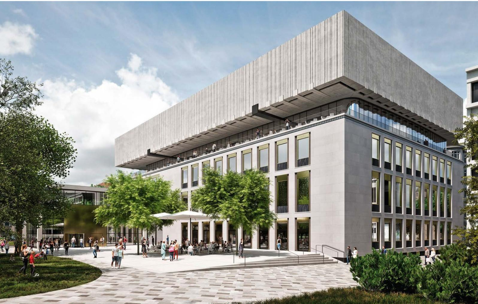
übernimmt der Stahl: Als Zugelement hängt er das gesamte obere Geschöß an den mittleren Betonstützen ab: Vier Hängebänder – sichtbar durch den Raum gespannt – bewältigen die gesamte Last eines Geschößes und leiten die Kräfte in die Betonstützen im Zentrum des Gebäudes. Sie vermitteln im öffentlichen Fugengeschöß den Eindruck, als schwebe das darüberliegende Gebäude, denn weder im Raum selbst noch an der Fassade trägt eine Stütze.
