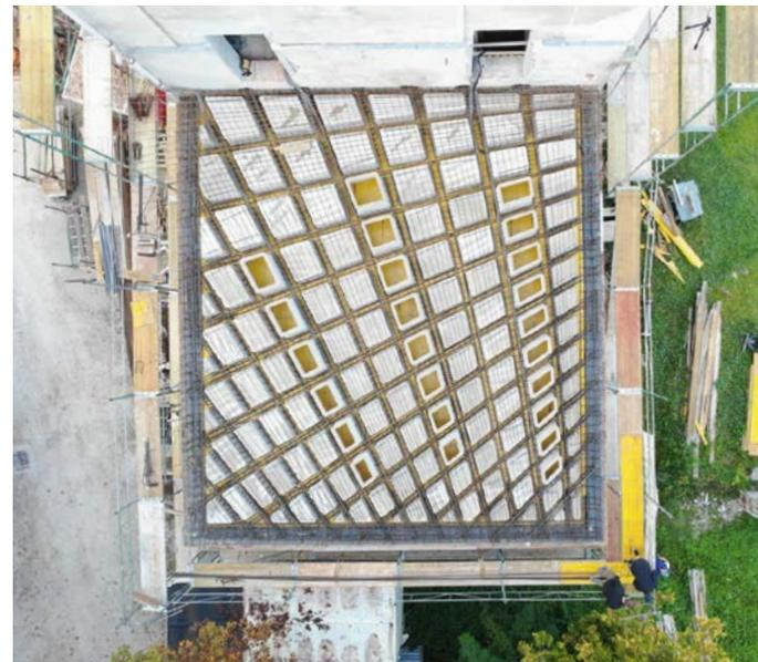
durch die Decke in einer stetigen dynamischen Umformung begriffen zu sein. Die individuellen Halbfertigteile wurden im Roboter Design Labor der TU Graz in 3-D gedruckt. In nur zwei Wochen war der Druck fertig, insgesamt konnte durch die Bauweise an die 35 Prozent Beton gegenüber einer monolithisch ausgeführten Decke eingespart werden. Die effektive Printdauer betrug rund 18 Stunden, dabei wurde ein Printpfad von 18 Kilometern zurückgelegt. Von
