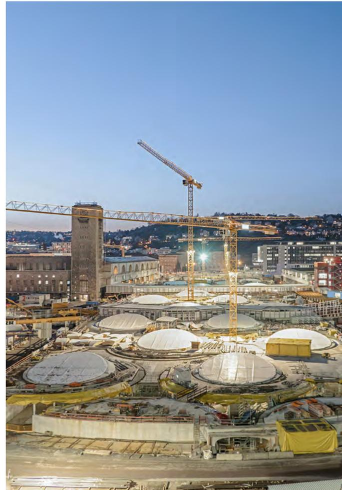
ausgelegt. Erst an den Übergängen zum Nord- und Südkopf finden sich Raumfugen. Die Anforderungen an den Massivbau sind durch die WU-Konstruktion des Troges und die Sichtbetonanforderungen (Sichtbetonklasse SB4) an die Weißbetonoberfläche des Schalendachs sehr hoch.
