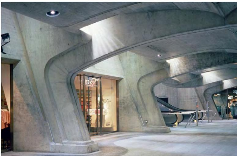
hinten von einer verankerten und aufgestapelten Wand und vorne von einer Reihe schräger, sich verjüngender Dreipunktstützen gestützt wurde.
