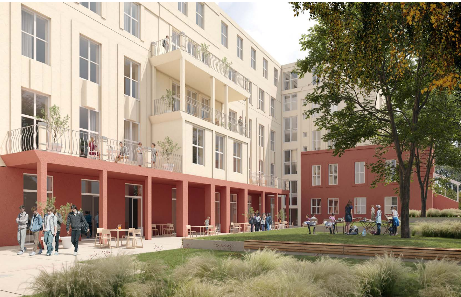
Schule der Zukunft: Am ehemaligen Standort des orthopädischen Krankenhauses Gersthof wird ein Schulstandort errichtet.
