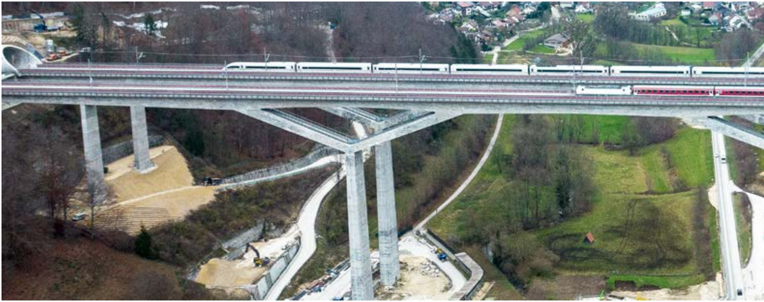
Wahrzeichen und zugleich Meisterwerk aus Beton für zukunftsgerichtete Infrastrukturbauten: die Filserbrücke in Deutschland
