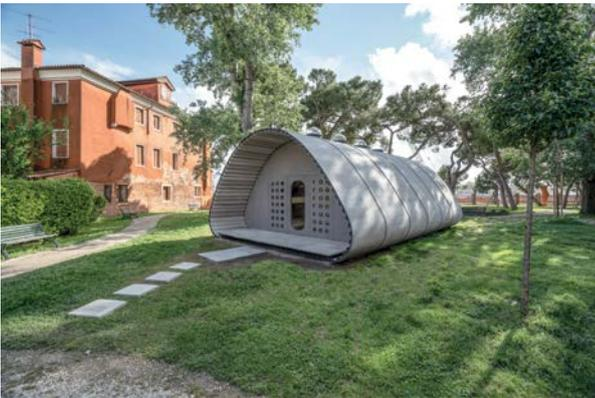
Airium-Schaum, ein mit Luftporen durchsetzter Dämmstoff auf Zementbasis. Das Essential Home wird auf eine spezielle Dachbahn gestellt, die das Eindringen von Feuchtigkeit verhindert. Das Essential Home ist in Modulbauweise konzipiert, sämtliche Bauteile können wiederverwendet werden.
