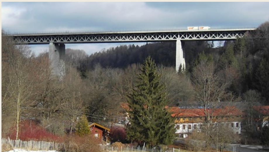
Die Mangfallbrücke aus den 60er-Jahren ist eine Spannbetonbrücke, sie gilt als Vorzeigebispiel für ein Betonfachwerk.
