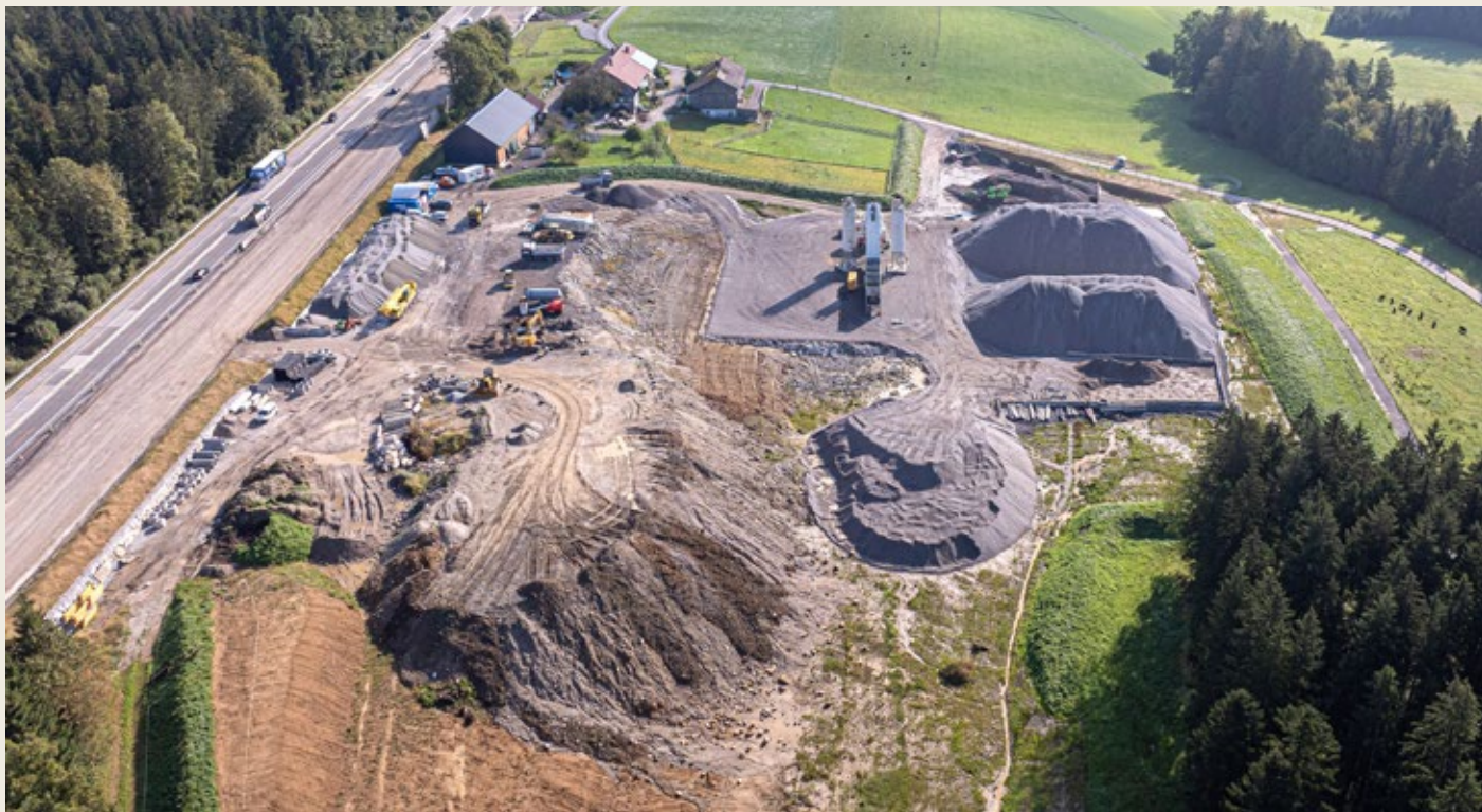
Der Betonbruch wurde direkt auf der Baustelle so aufbereitet, dass die Recycling-Gesteinskörnung nach der Aufbereitung der Körnung eines normalen Kieswerks entspricht.
