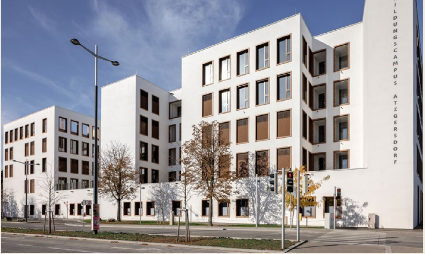
Der Bildungscampus Atzgersdorf Wien, nach allen Regeln der aktuellen Pädagogik errichtet und die hohen Klimaschutzansprüche der Baudirektion Wien erfüllend, geplant von Baumschlager Eberle Architekten, ist betonteilaktiviert und punktet mit thermischer Behaglichkeit und sehr niedrigen Betriebskosten.
