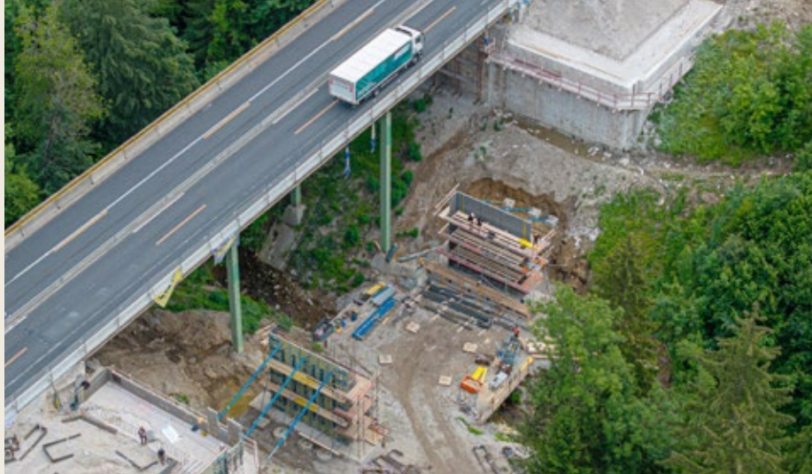
Die Generalsanierung wurde bei laufendem Verkehr durchgeführt, zudem wurden 28 Brücken erneuert wie hier die Ölgrabenbrücke.
