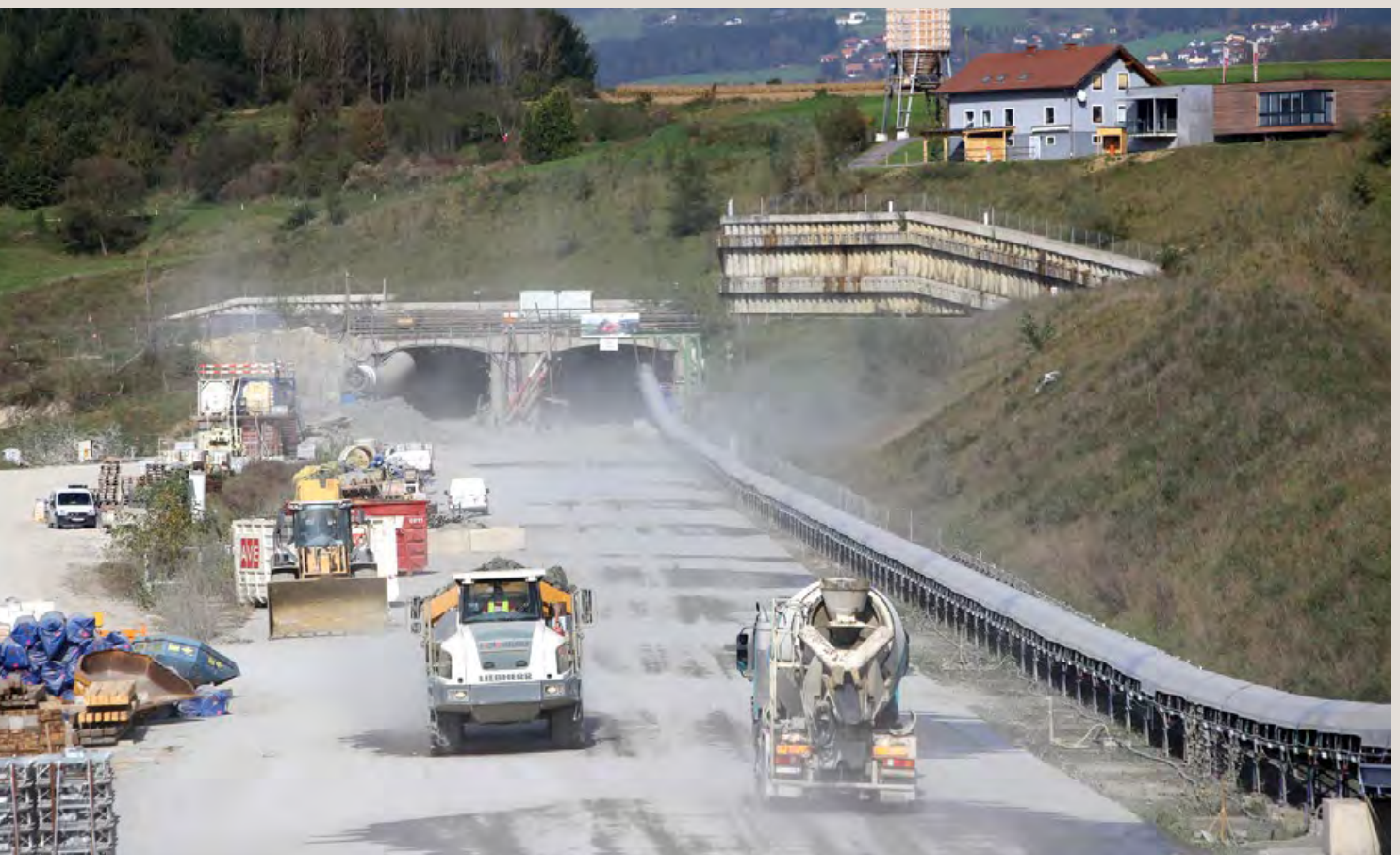
Ohne Beton geht nichts – wie hier beim Portal des Koralmtunnels auf Kärntner Seite.
