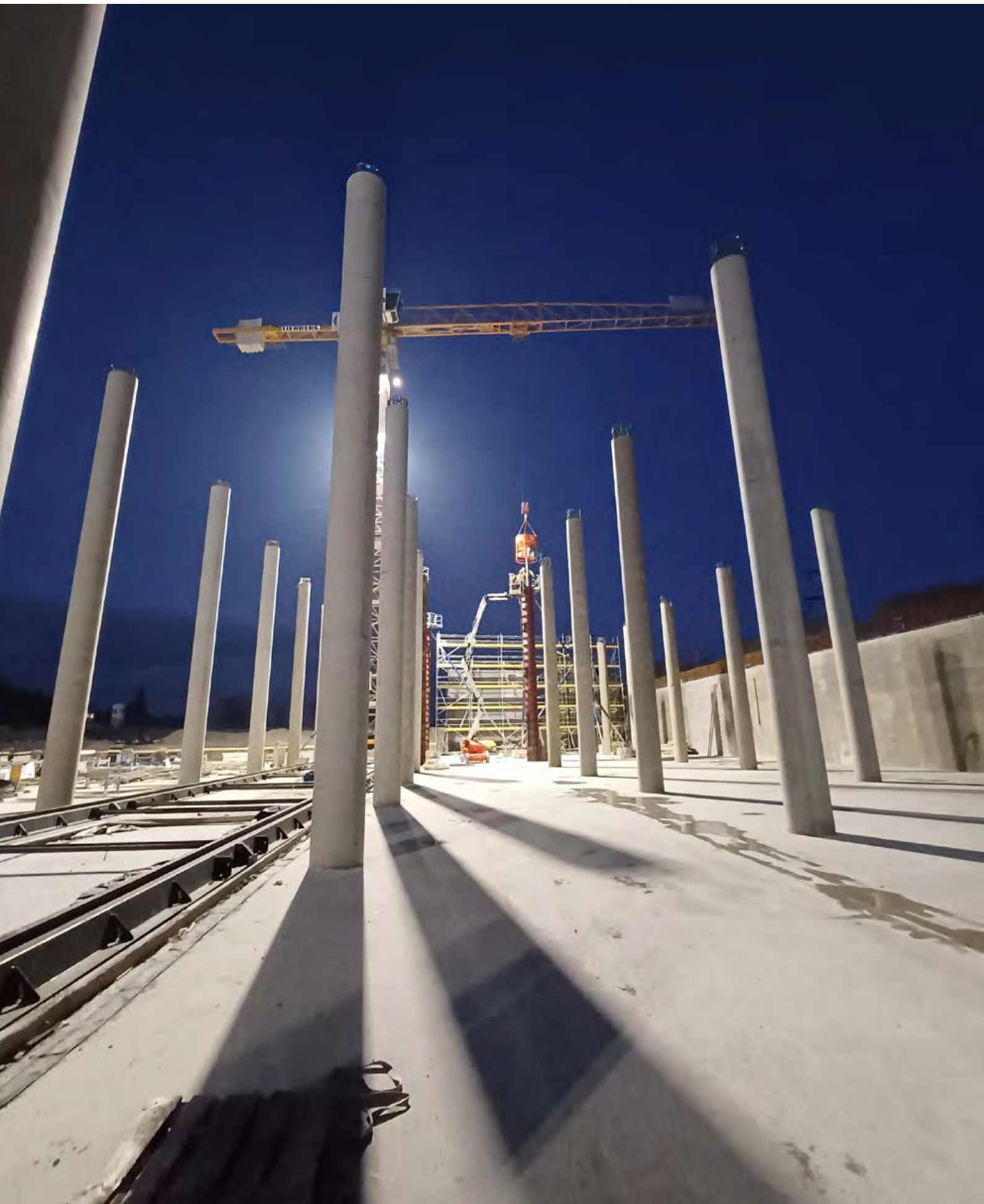
Spektakuläre, elf Meter hohe Betonsäulen, die die Decke des 21.000 Quadratmeter großen Wasserspeichers tragen werden.
