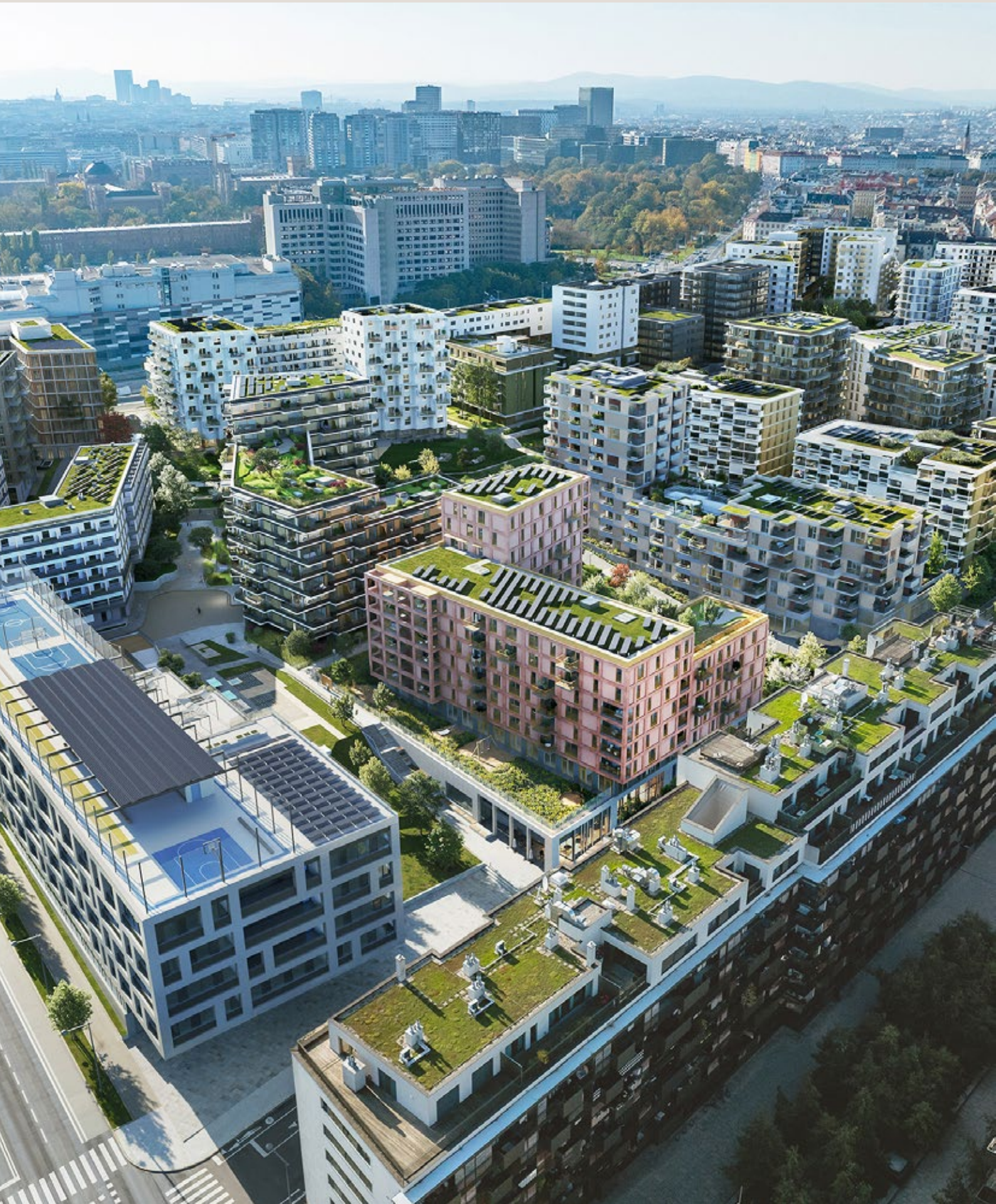
Das „Village im Dritten“, entsteht auf einer ehemaligen Brachfläche und erhielt das DGNB-Erschließungszertifikat für nachhaltige Stadtquartiere in Gold. Bis 2027 werden auf 22 Bauplätzen rund 2.000 Wohnungen errichtet. Leistbarkeit und ein europaweit einzigartiges Energiesystem, inklusive Betonteilaktivierung, stehen dabei im Zentrum.
