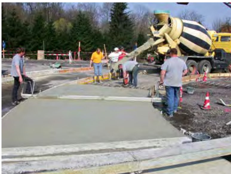
Abb.8–23: händischer Betoneinbau [8.15]
