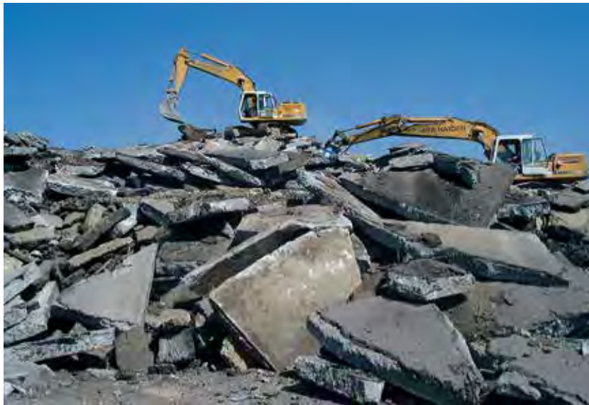
Abb.6-3: Zwischenlager des Straßenausbruchs (Foto Asamer Holding AG)
