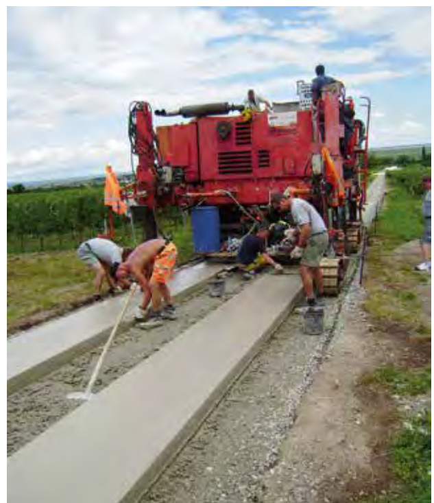
Abb.8–13: Einbau mit Fertiger, Betonspurweg Rust/Oggau (Foto VÖZf)
