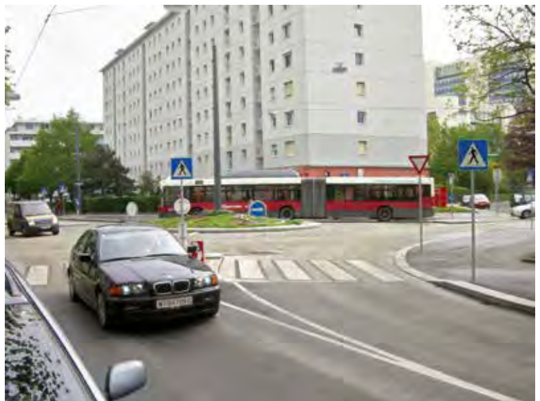
Abb.8–21: Kreisverkehr Forsthausgasse (Wien XX) – Ausfahrt in Asphalt
