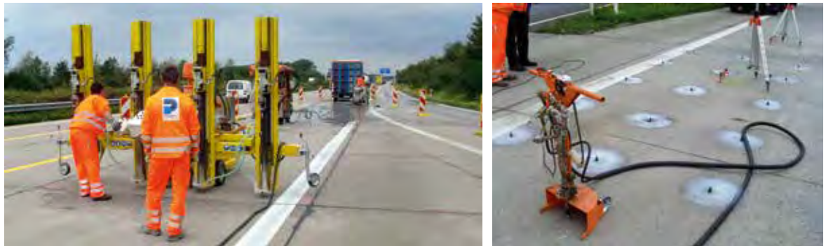
Abb.9-20: Heben und Festlegung von Platten
