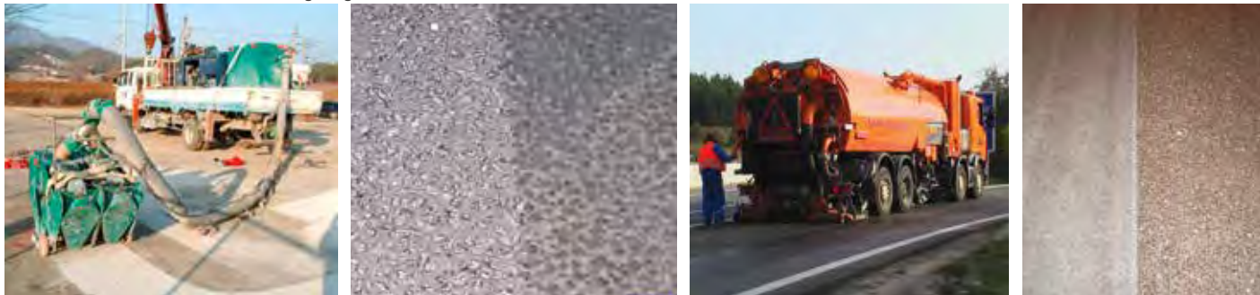
Abb.9–18: Oberflächenbearbeitung Kugelstrahlen, Hochdruckwasserstrahlen
