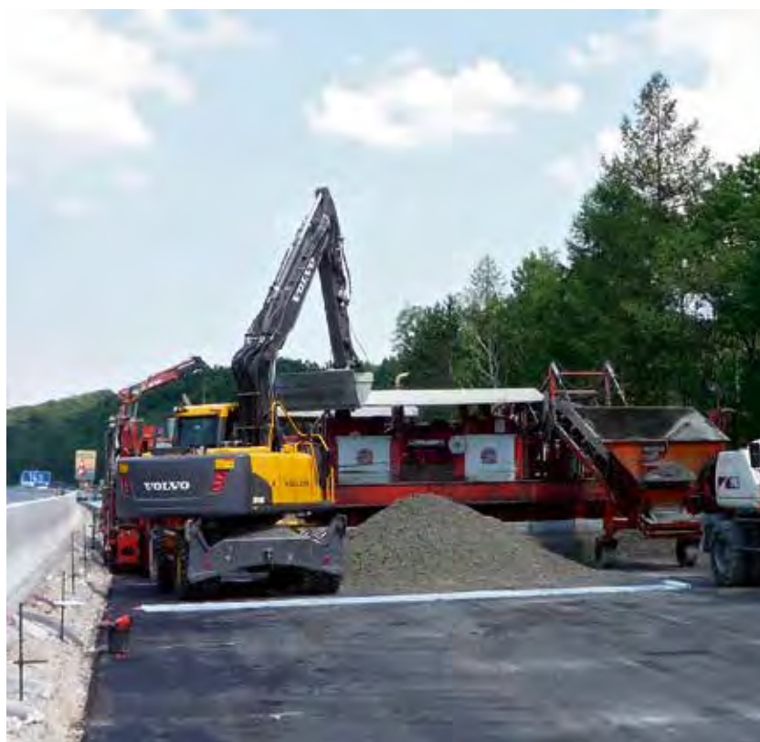
Abb.5-3: Betontransport und -einbau (VÖZff)
