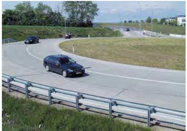
Abb.8–17: Kreisverkehr Schwechat, NÖ (Foto VÖZfi)
