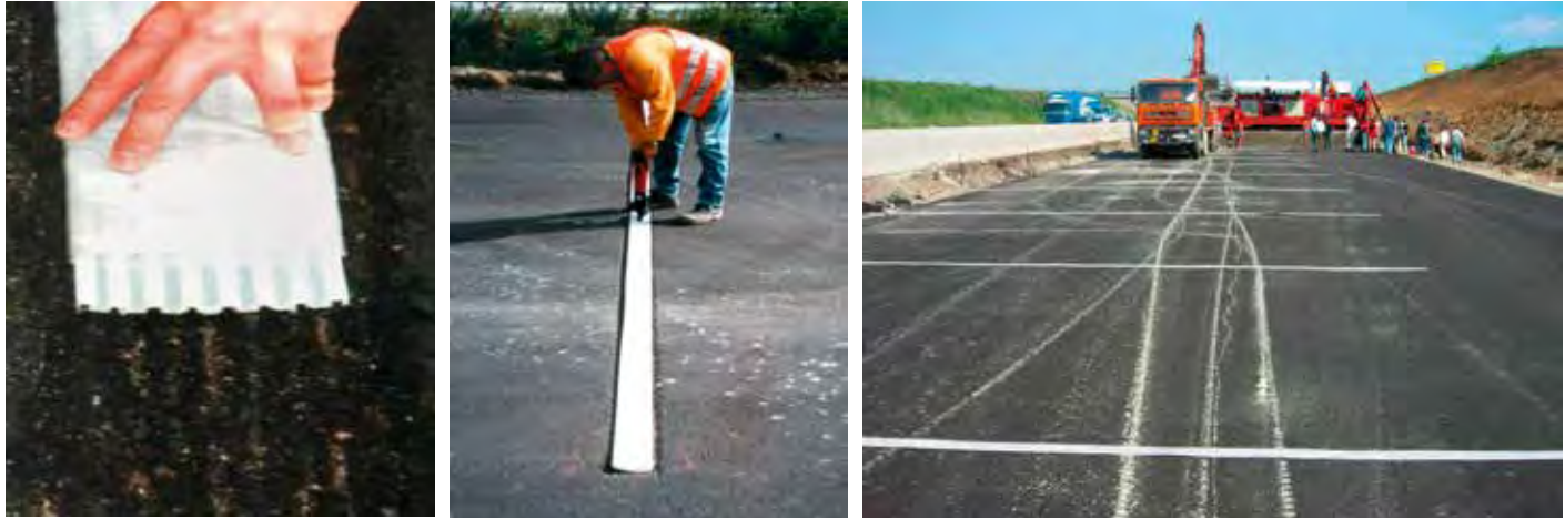
Abb.4–30: Flachdrains zur Entwässerung der Unterlage der Betondecke
