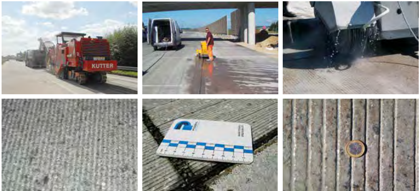
Abb.9–19:Oberflächenbearbeitung: Fräsen, Grinding und Grooving (v.l.n.r) und Resultate (untere Reihe)
