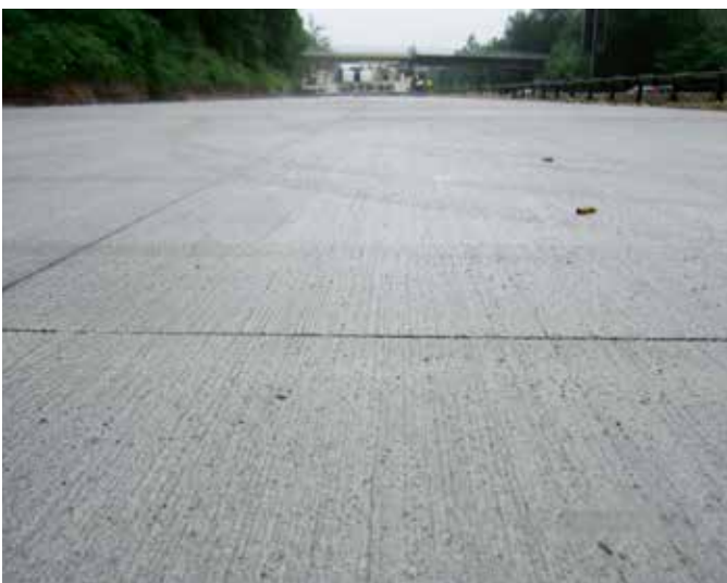
Abb.2-7: Oberflächentextur von Betondecken: Nachbehandlung durch Besenstrich links, Waschbetonoberfläche GK 8 mm rechts
