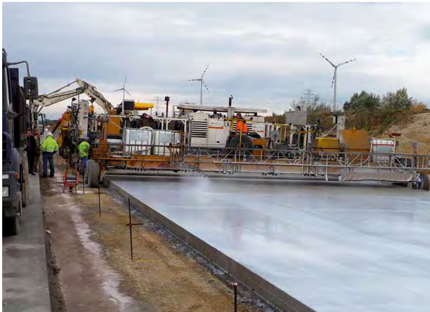
Abb.5–21: Aufbringen des ersten Nachbehandlungsmittels (Foto VÖZfi)
