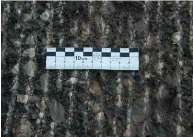
Abb.8-27: Fertige Oberfläche nach dem Fräsen – eine der wichtigsten Grundlagen für das Herstellen eines hochwertigen Verbundes (Foto VÖZfi)
