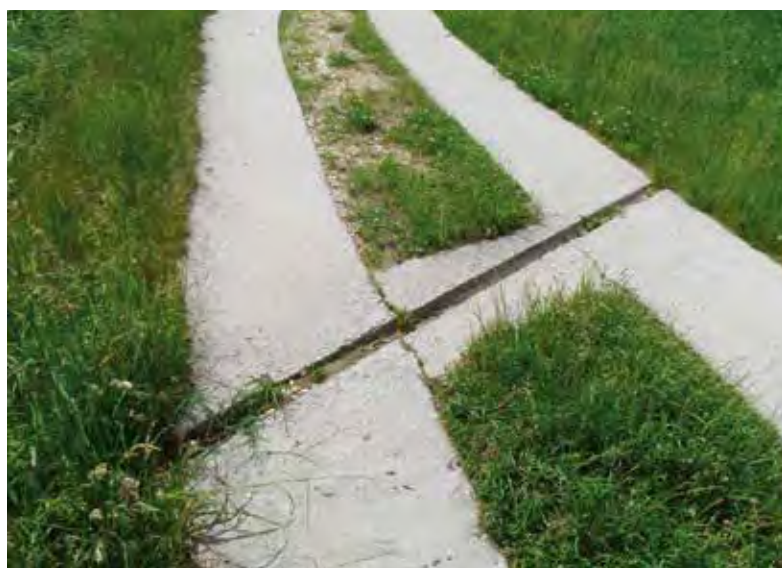
Abb.8–15: Querentwässerungsrinne (Foto VÖZfi)
