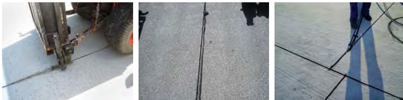
Abb.9–11: Fugenpflege bei Betondecken
