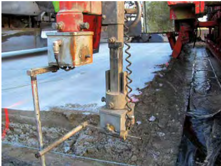
Abb.5-4: Leiteinrichtung Gleitschalungsfertiger (VÖZfi)
