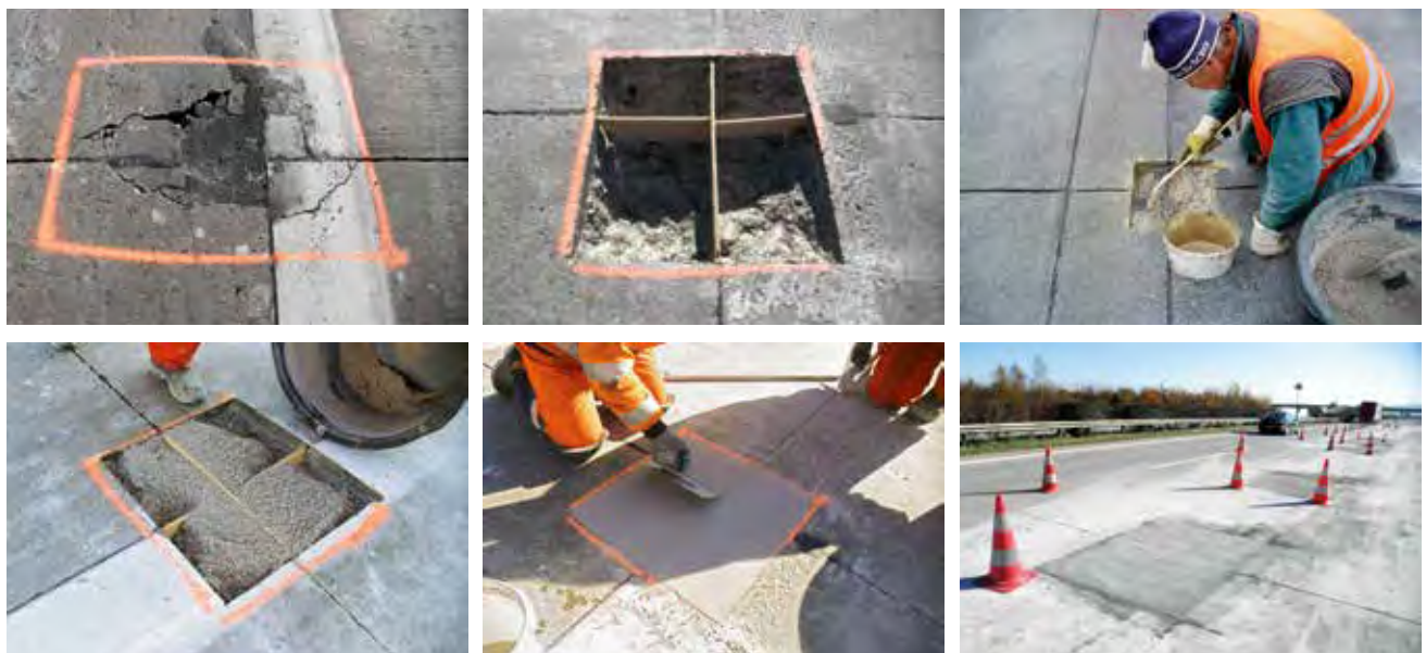
Abb.9–17: Arbeitsschritte Sanierung Kantenschaden
