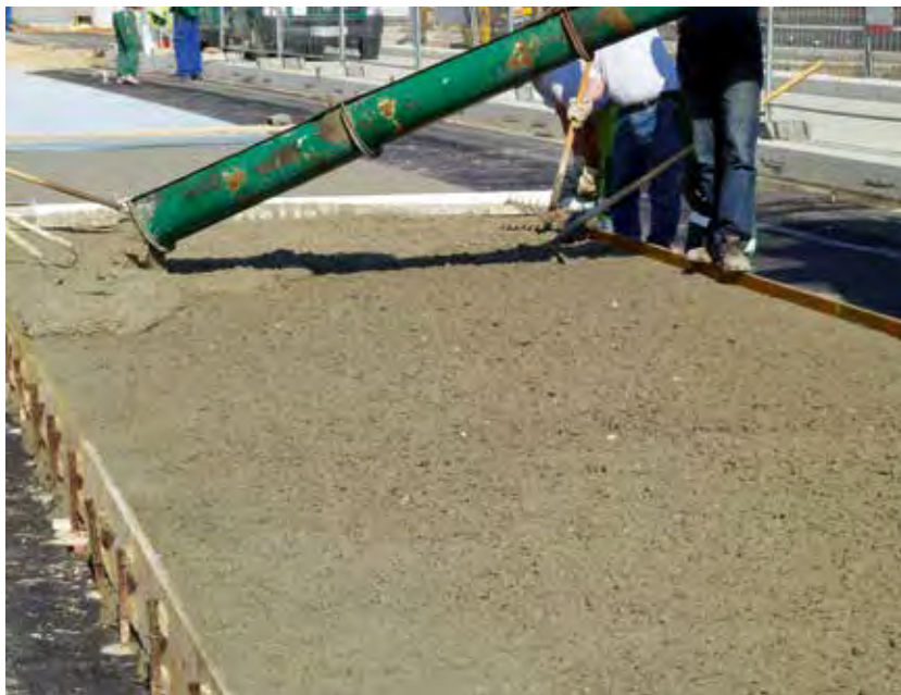
Abb.5-5: Schalung für händischen Einbau (VÖZfi)
