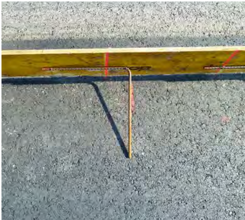
Abb.5–9: Aufgebogene Anker (VÖZfi)
