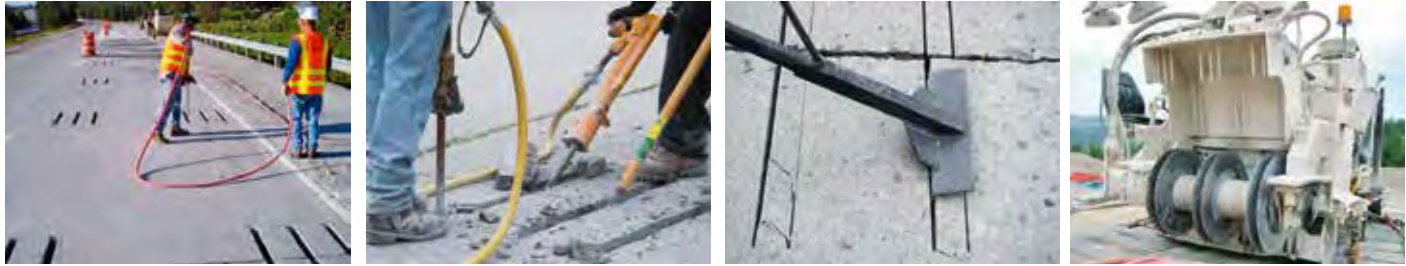
Abb.9–13: Arbeitsschritte Nachträgliches Verdübeln und Verankern
