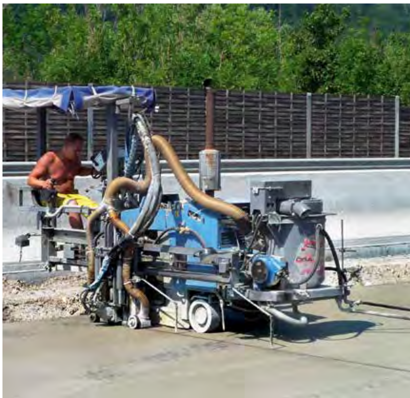
Abb.5– 19: Schneiden von Scheinfugen (Foto VÖZfi)
