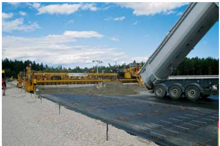
Abb.8–30: Ausführung einer Verkehrsfläche aus Beton auf einer Rastanlage
