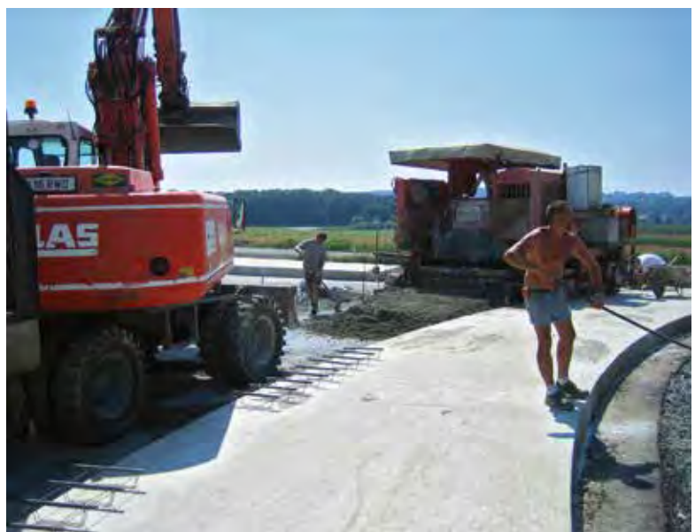
Abb.8–22: Betoneinbau mit Fertiger [8.15]
