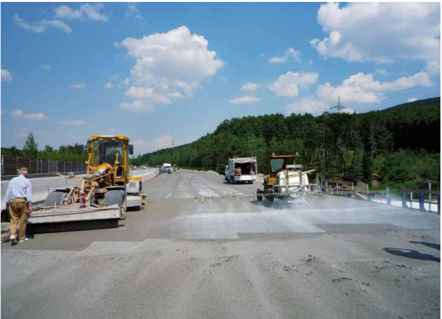
Abb.5–22: Aufbringen des zweiten Nachbehandlungsmittels nach dem Ausbürsten (Foto VÖZfi)
