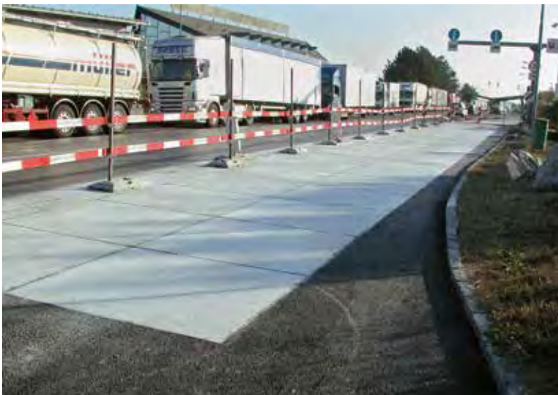
Abb.8-29: White Topping Strecke Grenzübergang Berg (NÖ) – Oktober 2006 (Foto VÖZfi)
