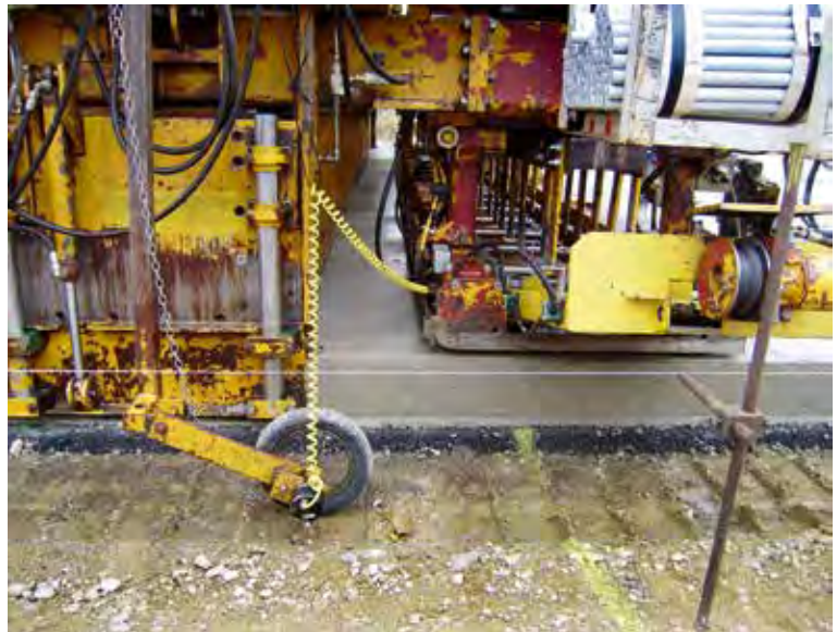
Abb.5–6: Dübelsetzgerät am Gleitschalungsfertiger (VÖZfi)
