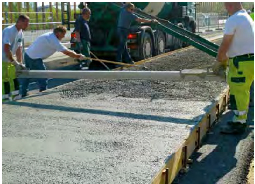
Abb.5–14: Händisches Einbringen, Verdichtung und Glätten des Betons (VÖZfi)
