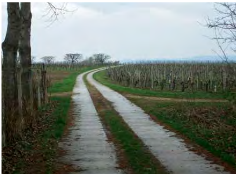
Abb.8–14: Betonspurweg Horitschon (Foto VÖZfi)
