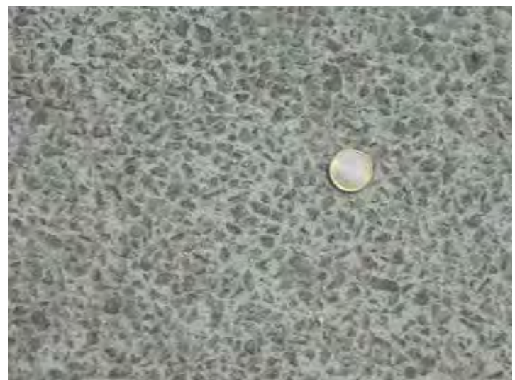
Abb.2-7: Oberflächentextur von Betondecken: Nachbehandlung durch Besenstrich links, Waschbetonoberfläche GK 8 mm rechts
