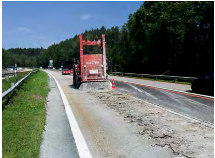
Abb.6–2: Bearbeitung mittels Fallschwert (Foto R. Spörr)
