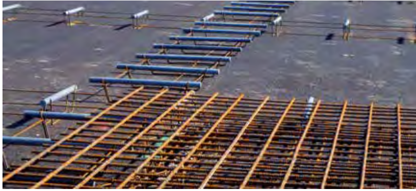
Abb.5–8: Feldbewehrung (bei der Ausführung von Schwerpunktrastplätze) (VÖZfi)
