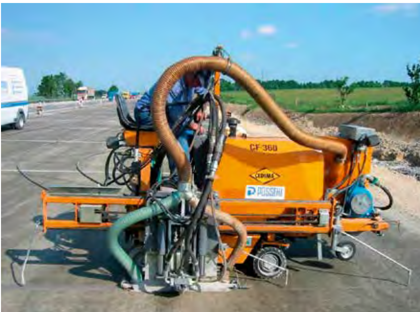
Abb.4–9: Herstellung des Stufenschnitts
