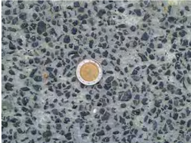
Abb.5–15: Oberflächenausbildung als Waschbeton (Foto VÖZfi)
