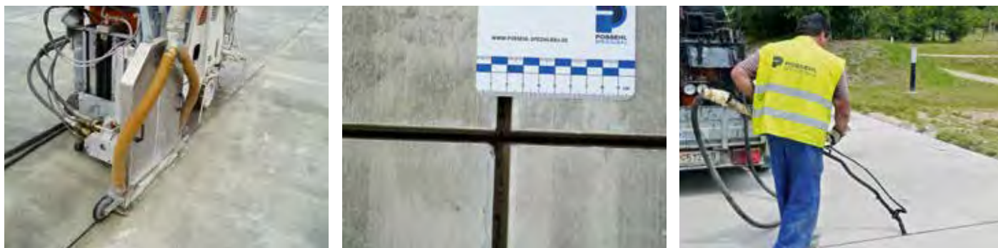
Abb.9–12: Arbeitsschritte bei der Fugenerneuerung mit Heißvergussmasse
