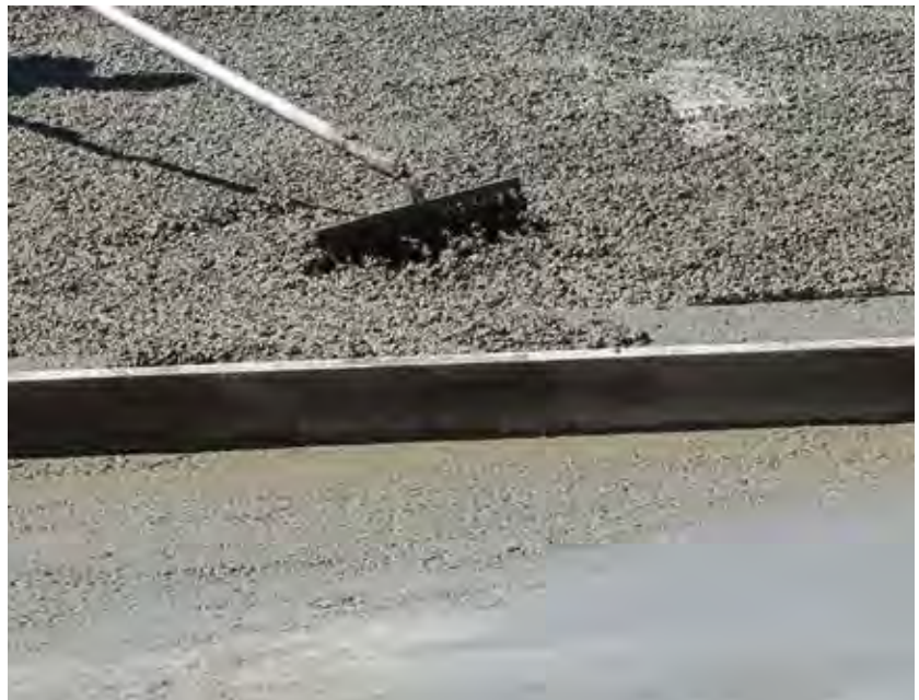
Abb.5–13: Händisches Einbringen von Beton (VÖZfi)
