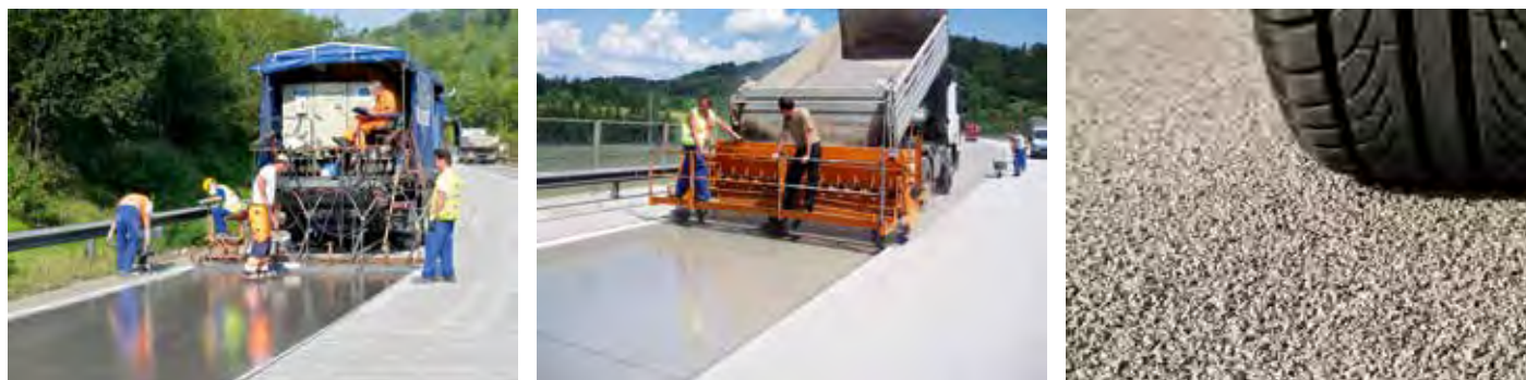
Abb.9–24: Oberflächenbehandlungen von Betondecken (Epigrip)
