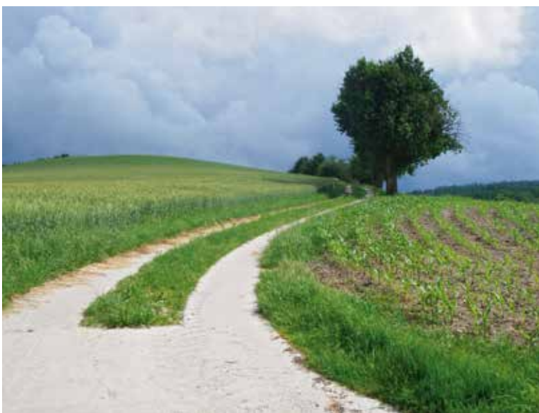
Abb.8–16: Fertiger, begrünter Betonspurweg „Dallinger“, OÖ (Foto VÖZfi)
