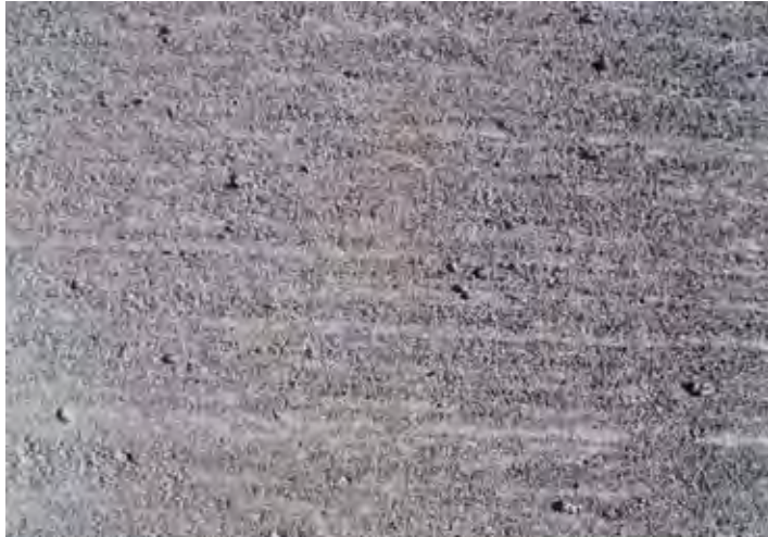
Abb.5–17: Oberflächenausbildung durch Besenstrich (Foto VÖZfi)
