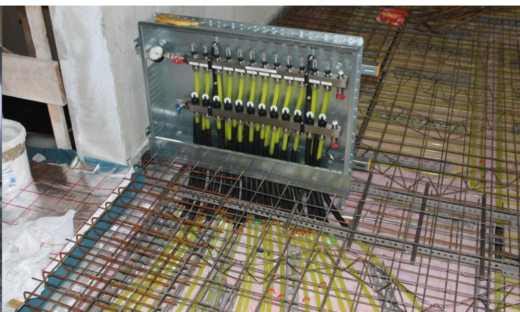
DETAIL: BAUKERNAKTIVIERUNG HEIZUNG/ KÜHLUNG- FUGE - HALLE VERTEILER BAUKERNAKTIVIERUNG HEIZUNG/ KÜHLUNG-HALLE
