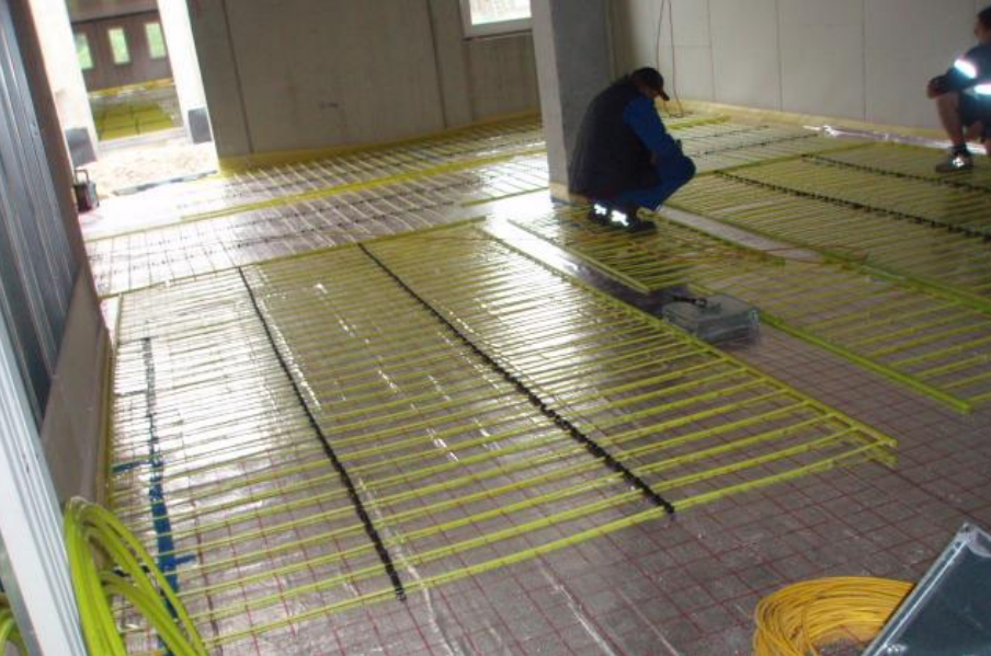
BAUKERNAKTIVIERUNG HEIZUNG/ KÜHLUNG - BÜRO BAUKERNAKTIVIERUNG HEIZUNG/ KÜHLUNG- HALLE
