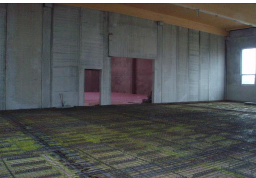
BAUKERNAKTIVIERUNG HEIZUNG/ KÜHLUNG - BÜRO BAUKERNAKTIVIERUNG HEIZUNG/ KÜHLUNG- HALLE
