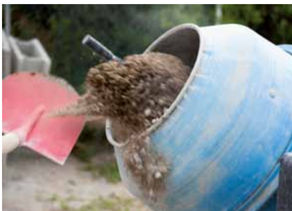
Abb. 16: Geringe Menge Korngemisch in den Mischer geben.
