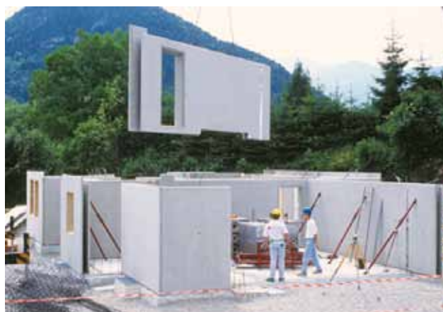
Abb. 27: Kranabladung von Betonfertigteilen
