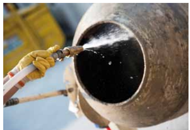
Abb. 25 + 26: Nach dem Betonieren sind alle Geräte sorgfältig zu reinigen
