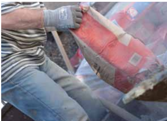
Abb. 14: Öffnen des Zementsacks.
