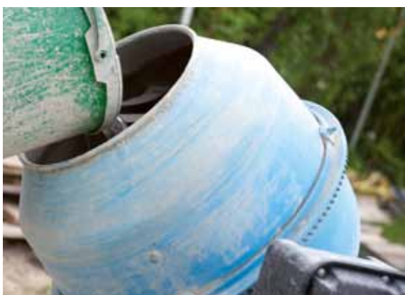
Abb. 15: Wasser in den Mischer geben.
