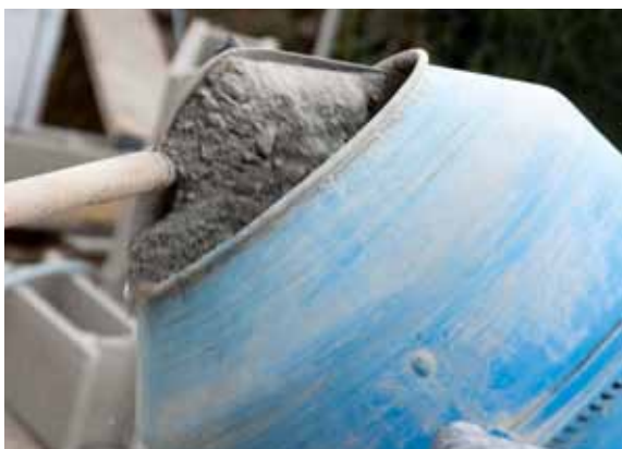
Abb. 17: Zement in den Mischer geben.
