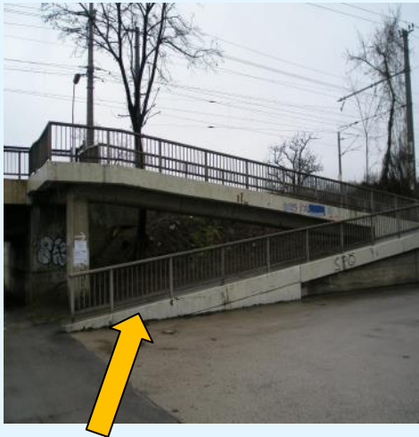
B024701 – „Rampenanlage bei der Ostbahn“
