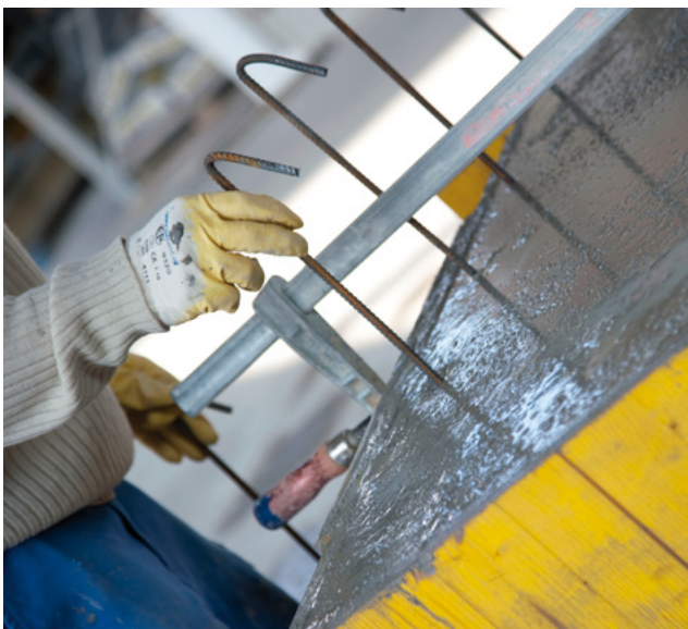
Abb. 22: Steckisen gewährleisten die Verbindung zwischen Betonierabschnitten.
