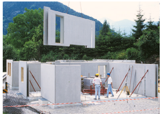
Abb. 28: Kranabladung von Betonfertigteilen
