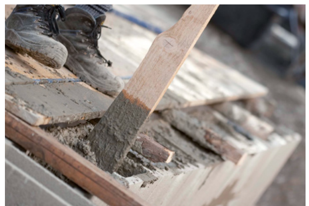
Abb. 21: Sorgfältige Verdichtung ist wichtig.
