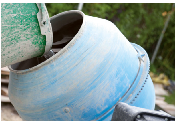
Abb. 15: Wasser in den Mischer geben
