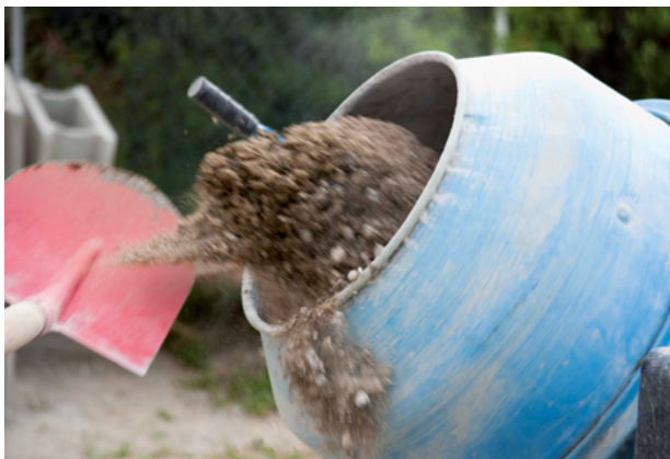
Abb. 16: Geringe Menge Korngemisch in den Mischer geben
