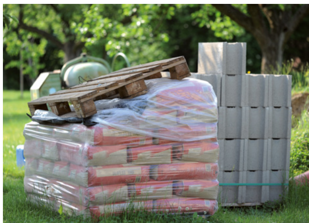
Abb. 1: Ordnung auf der Baustelle erleichtert den Arbeitsablauf.
