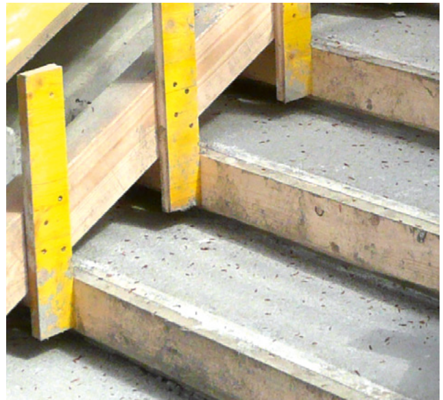
Abb. 25: Schalungen so lange wie möglich belassen
