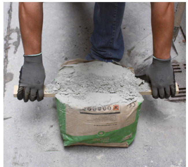
Abb. 13: Sackteilung durch Schaufel- oder Messerschnitt
