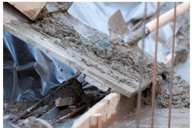
Abb. 20: Frischen Beton sofort verarbeiten
