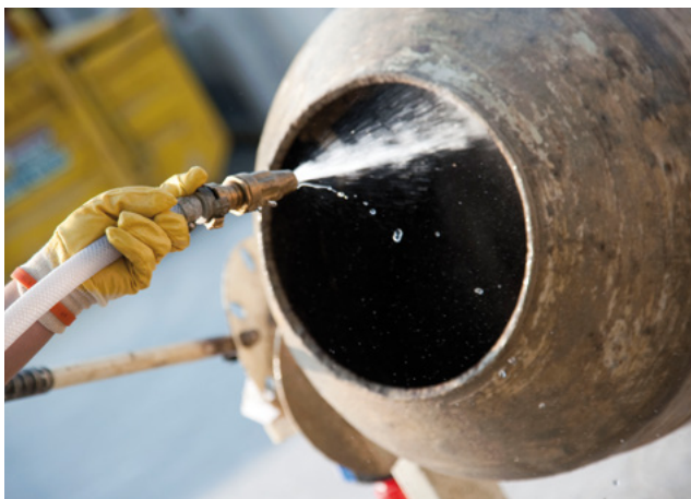
Abb. 26 + 27: Nach dem Betonieren sind alle Geräte sorgfältig zu reinigen
