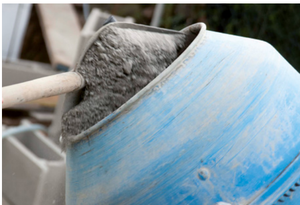
Abb. 17: Zement in den Mischer geben
