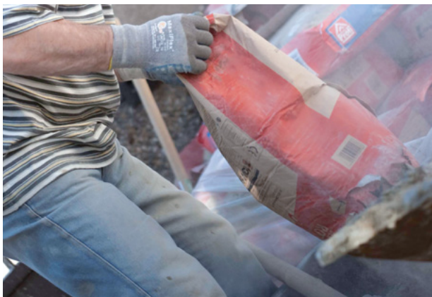
Abb. 14: Öffnen des Zementsacks
