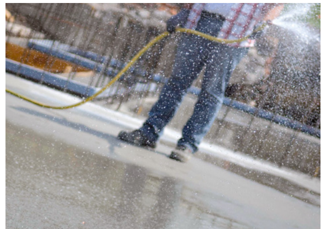
Abb. 24: Besprühen der frischen Betonoberfläche mit Wasser
