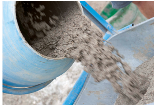
Abb. 18: Frischbeton mit einer Scheibtruhe transportieren
