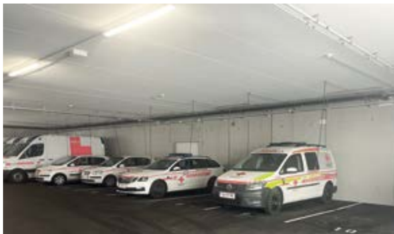
Die Wände der Halle sind aus Ortbeton, die Decke aus Betonfertigteilen.
