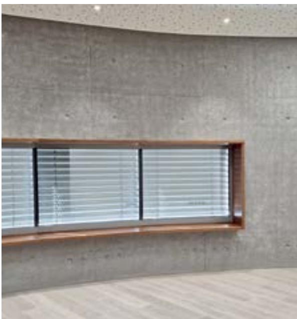
Perfekte Sichtbetonwände dominieren die Apotheke im Inneren.
