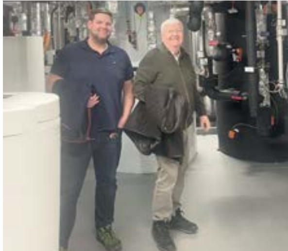
Die Haustechnikzentrale ist das Herz des neuen Gebäudes – die Bauteilaktivierung sorgt für eine gleichmäßige Temperatur das ganze Jahr hindurch.
