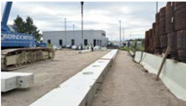
Rund 300 Betonfertigteile wurden wiederverwendet.
