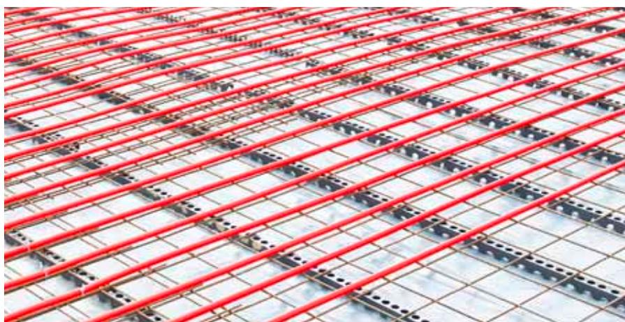
Auf der unteren Stahlbewehrung montierte Leitungsrohre
