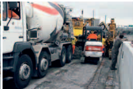
2 Anlieferung des Betons mittels Fahrmischer. Ein Kleinbagger verteilt den Beton.
