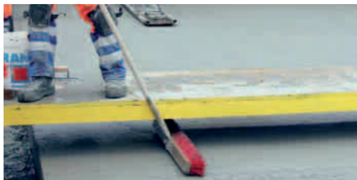
4 Mit dem Besen wird der noch weiche Beton in Querrichtung gerillt, um die Griffbarkeit des Belags zu erhöhen.
