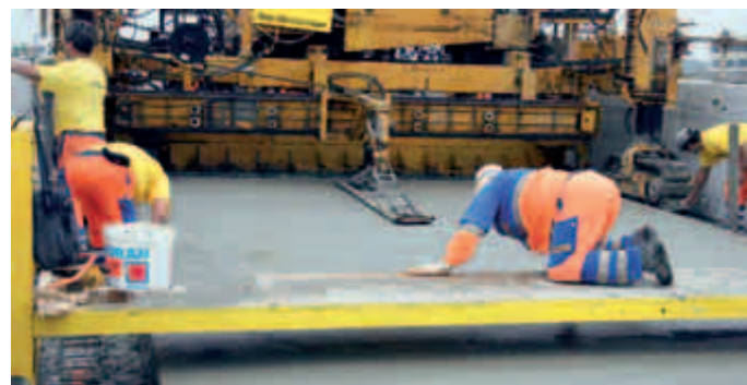
3 Der schwebende Längsglätter taloschiert die Oberfläche ab; mit der Kelle werden die letzten Unebenheiten ausgeglichen.
