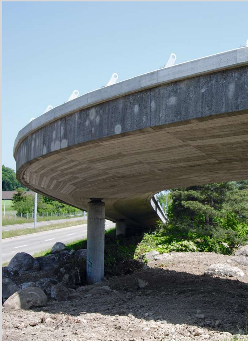
Instand gesetzte Brüstung der Rampe Nord
