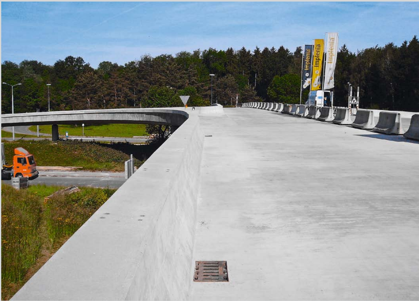
Einsteinbrücke mit neuem Betonbelag und vorbetonierter Brüstung
