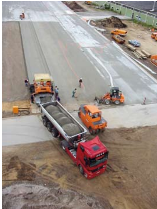
Bild 3: Walzbetoneinbau in Bahnen [1]
