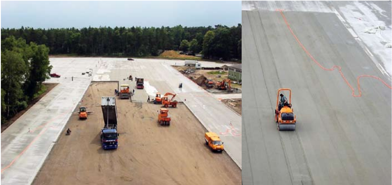
Bild 1: Walzbetoneinbau im Materialdepot Hesedorf [1]
