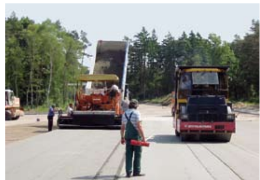
Bild 2: Abwalzen mit einer 16-t-Glattmantelwalze [1]
