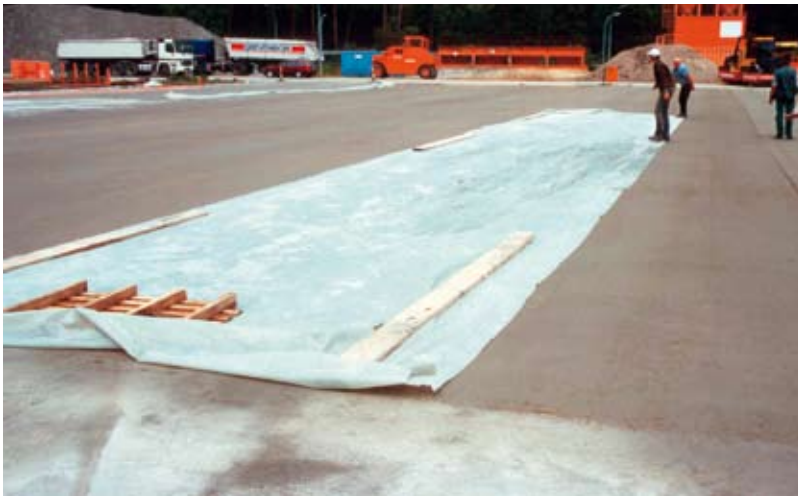
Bild 5: Abdeckung mit Folie bei Regenrisiko [1]
