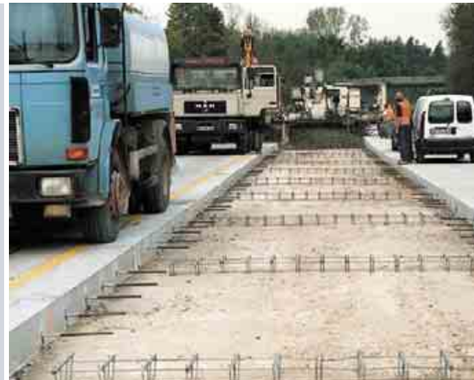
Bild 2: Verbelung und Verankerung von Betonfahrstreifen im Kreuzungsbereich
