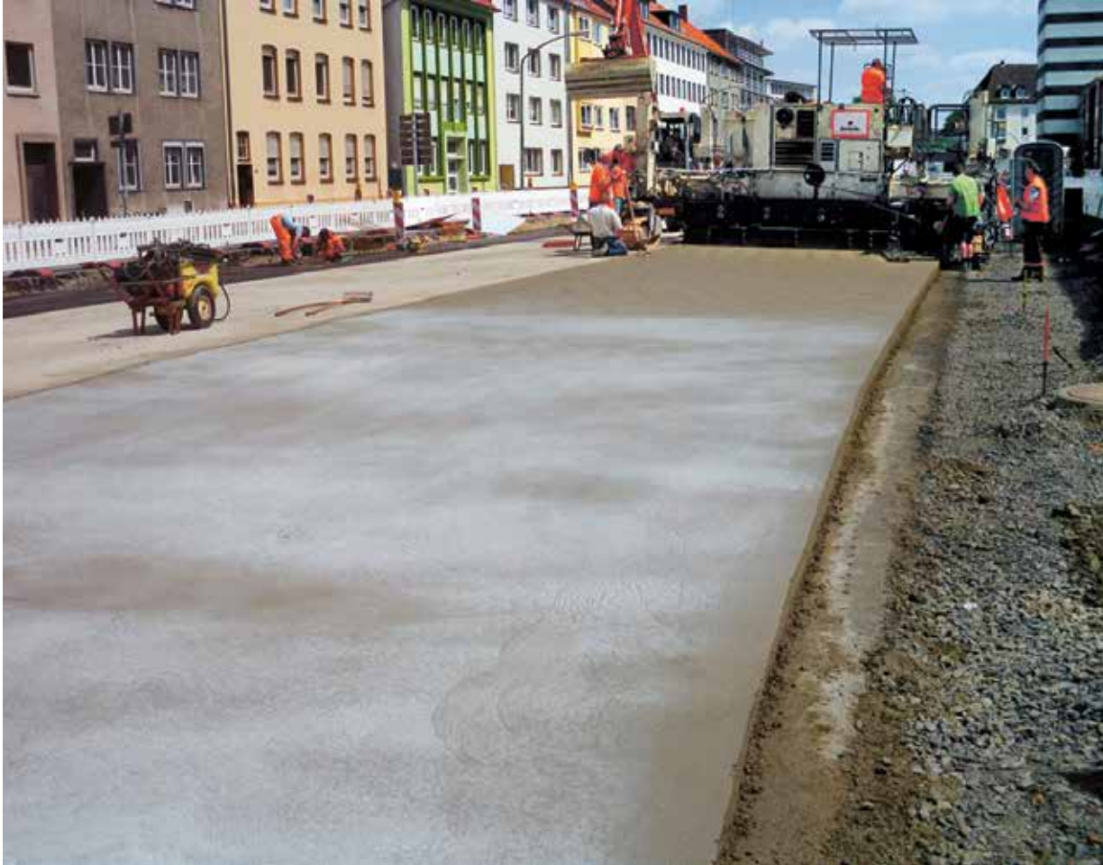
Abb. 6 Herstellen des Unterbetons
