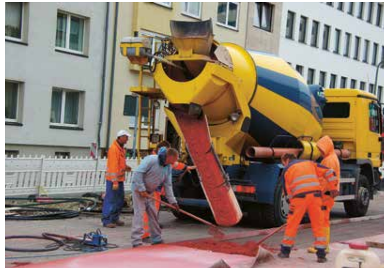
Abb. 7 Einbau des eingefärbten Oberbetons
