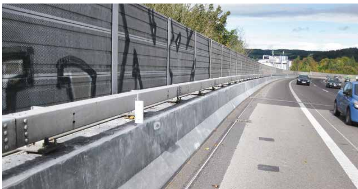
Abb. 5 Fertiggestellte mit UHFB beschichtete Leitmauer
