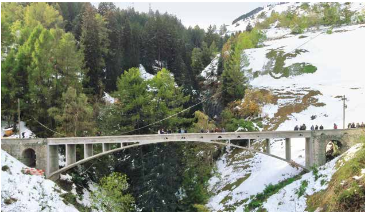
Abb. 7 Brücke nach der sanften Instandsetzung
