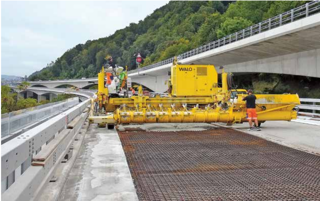
Abb. 14 Maschineller Einbau des UHFB mit einem eigens umgebauten Strassenfertiger
