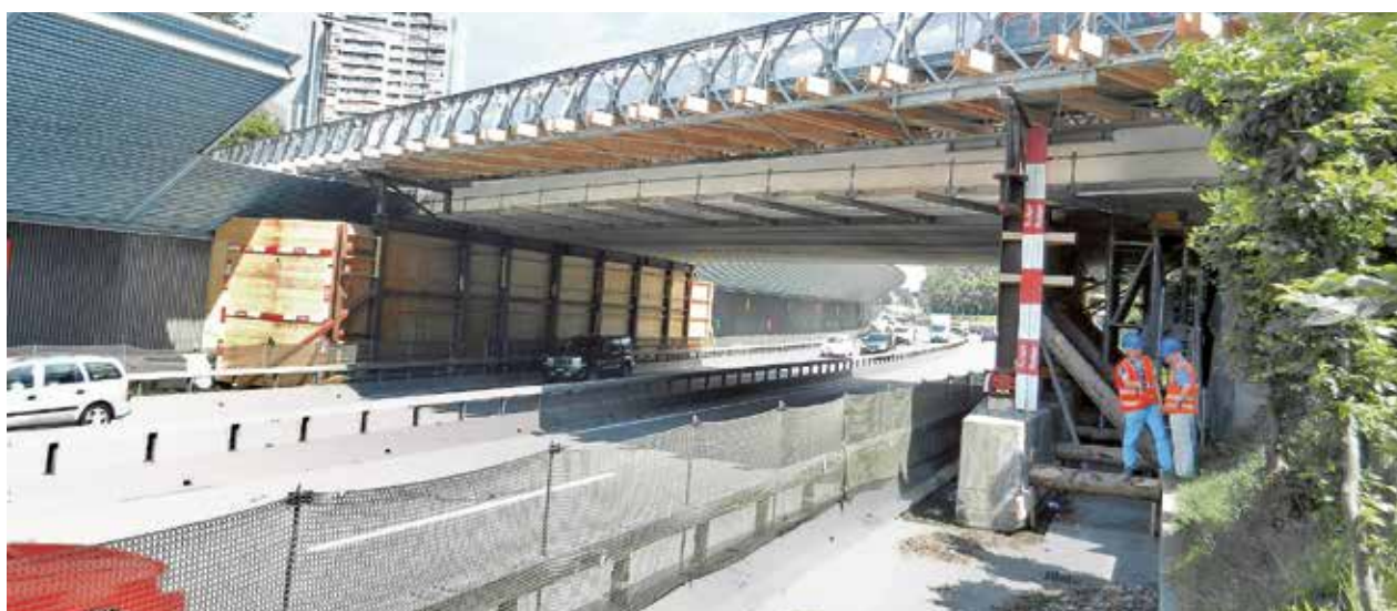
Abb. 13 Blick auf die bereits fertig gestellte Fahrbahnhälfte; Untersicht des Überführungsbauwerks
