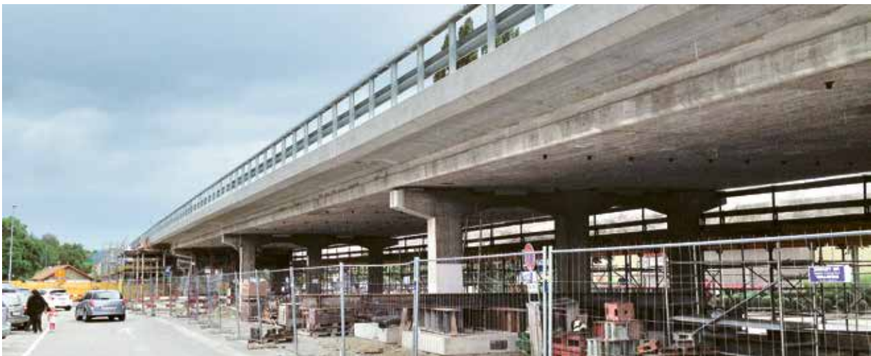
Abb. 11 Untersicht der instandgesetzten Randabschlüsse
