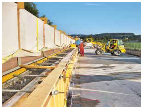
Abb. 4 Vorbereitete Schalung für die Beschichtung
