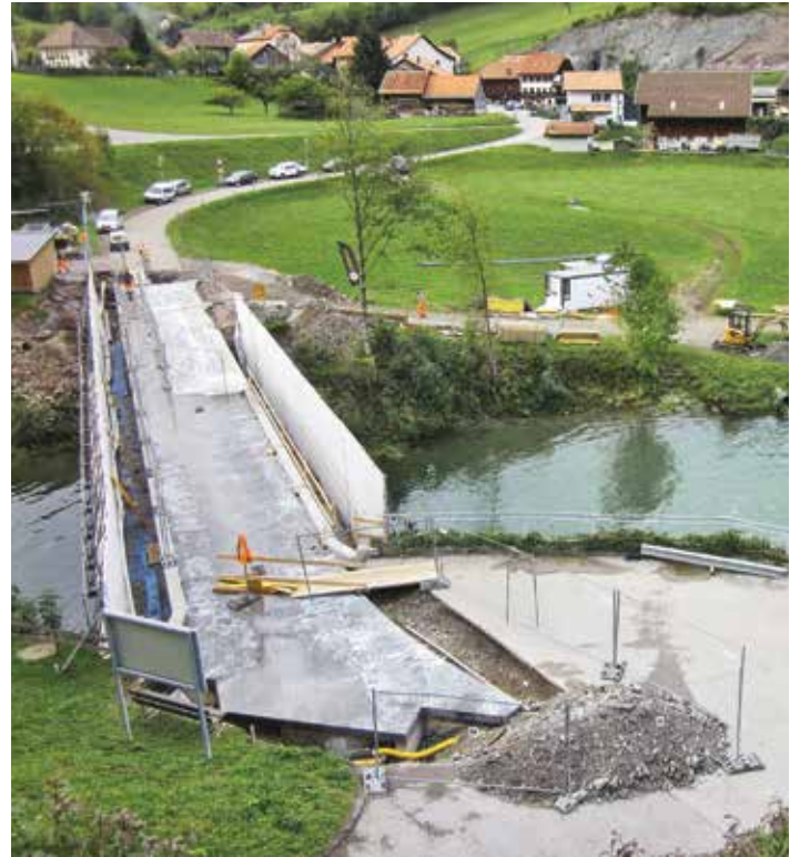
Abb. 8 Überblick Brücke in Montbovon während Instandsetzung
