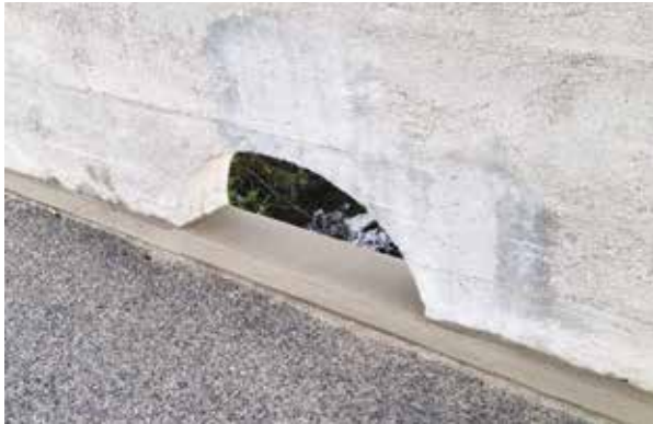
Abb. 6 Detail zur Oberflächenausbildung mit eingestreutem Splitt
