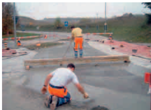
Einstreuen des Hartstoffes, Fertigung der Belagsoberfläche
