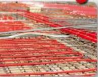
4 Befestigung mittels Kabelbinder
