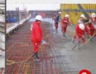
8 Betonieren des Bauteils unter Aufrechterhaltung des Drucks.
