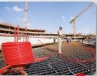
3 Verlegen der Rohrleitungen nach Verlegeplan
