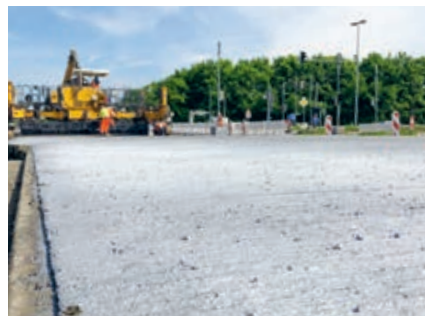
Aufgesprühtes weiß eingefärbtes Curing zur Nachbehandlung
