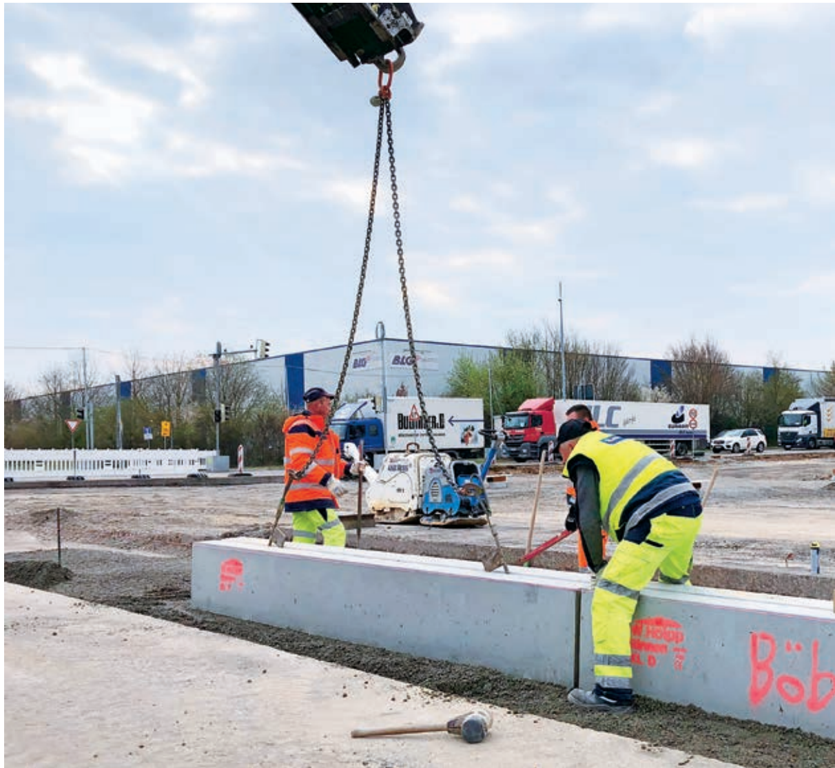
Tiefbauarbeiten, neue leistungsfähigere Straßenentwässerung
