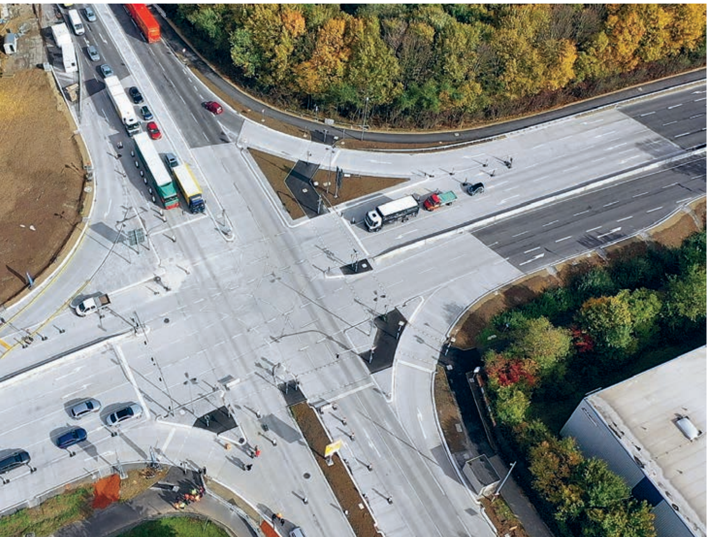
Luftaufnahme des fertiggestellten Daimler-Knotens
