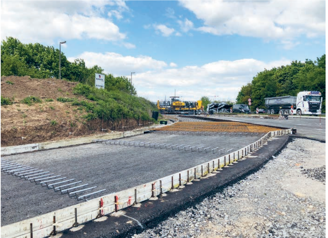
Vorbereitung Betonage mit bewehrtem, geometrisch kritischem Feld; Vorlegen der Dübel in Körben unterhalb der späteren Querscheinfuge
