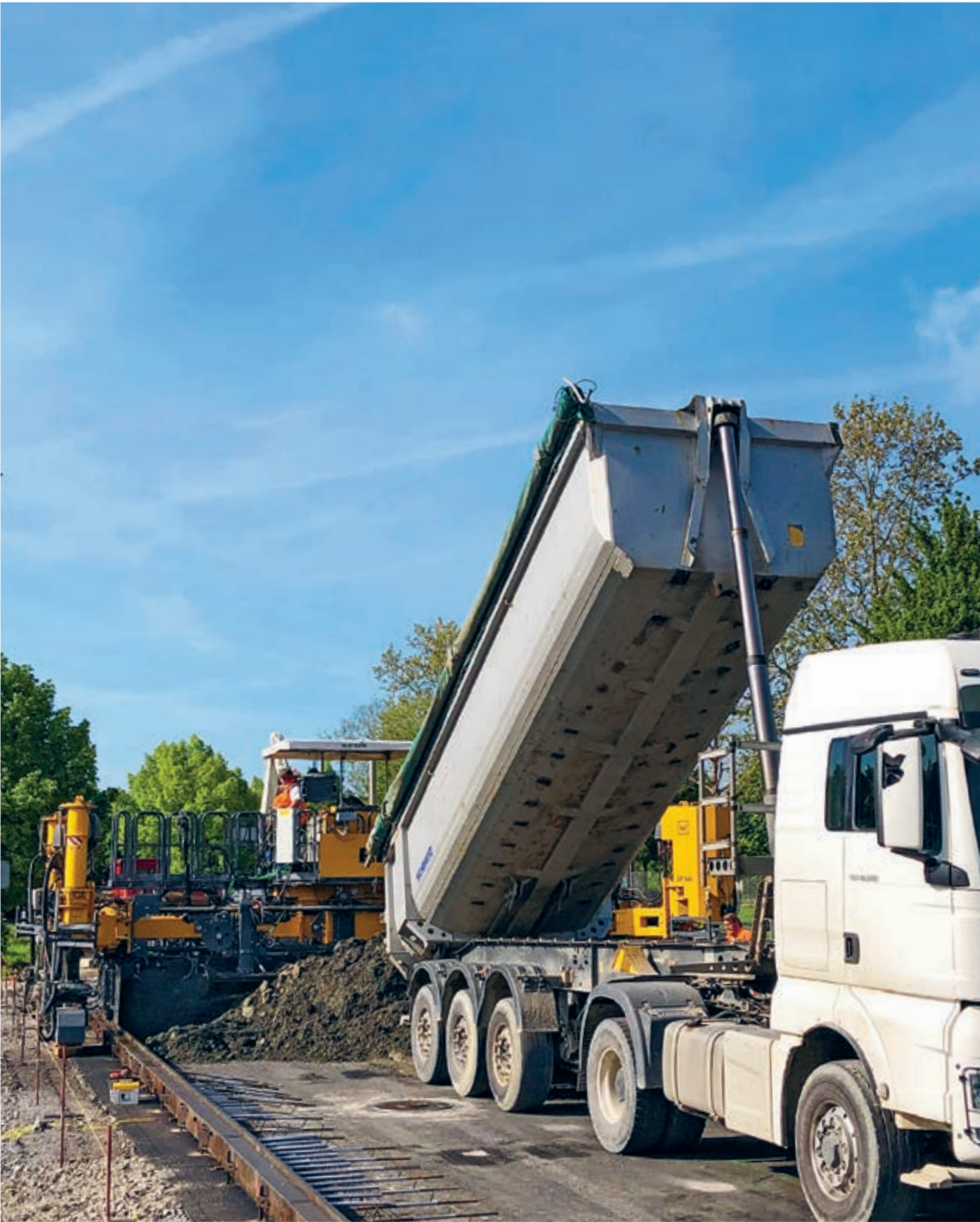
Betoneinbau mit Beton-Straßenfertiger in der Konsistenzklasse C1
