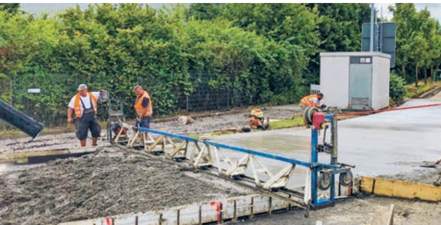
Betoneinbau mit der Rüttelbohle in der Konsistenzklasse F3
