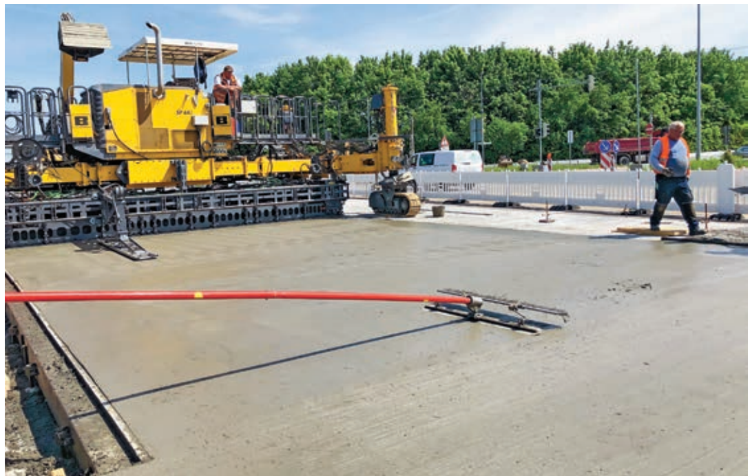
Aufbringen des Besenstrichs
